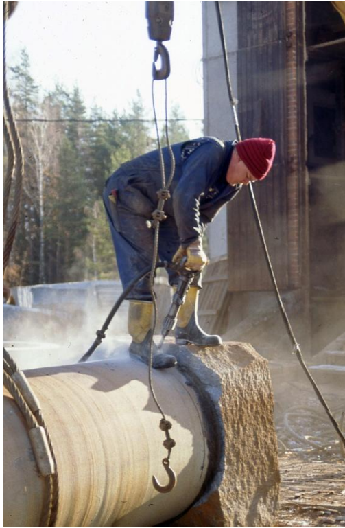
Kuva 18. Pohjan katkaisu: kiiloille porataan reiät. Kuva: Arto Peltola.
