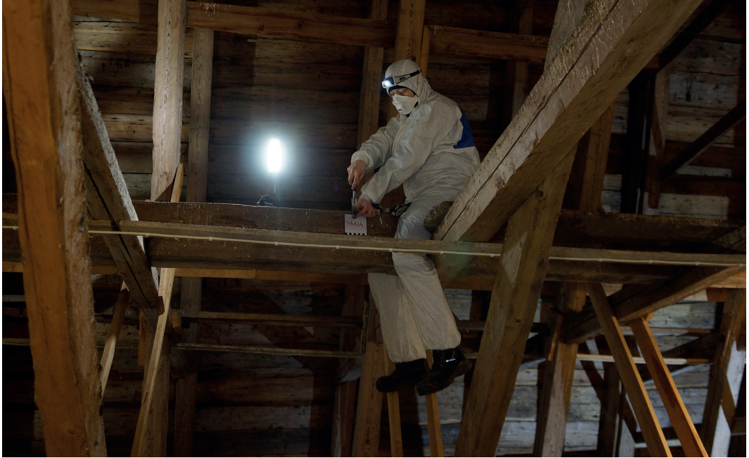
Kuva 5. Rakenteiden yksikkönumerointia Pohjan kirkossa. Kuva: M. Tolonen
