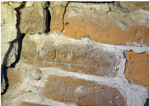
Kuva 9. Tiilentekijän merkki Karjaan kirkon muurinsisäisessä kierreportaassa. Kuva: M. Tolonen.
