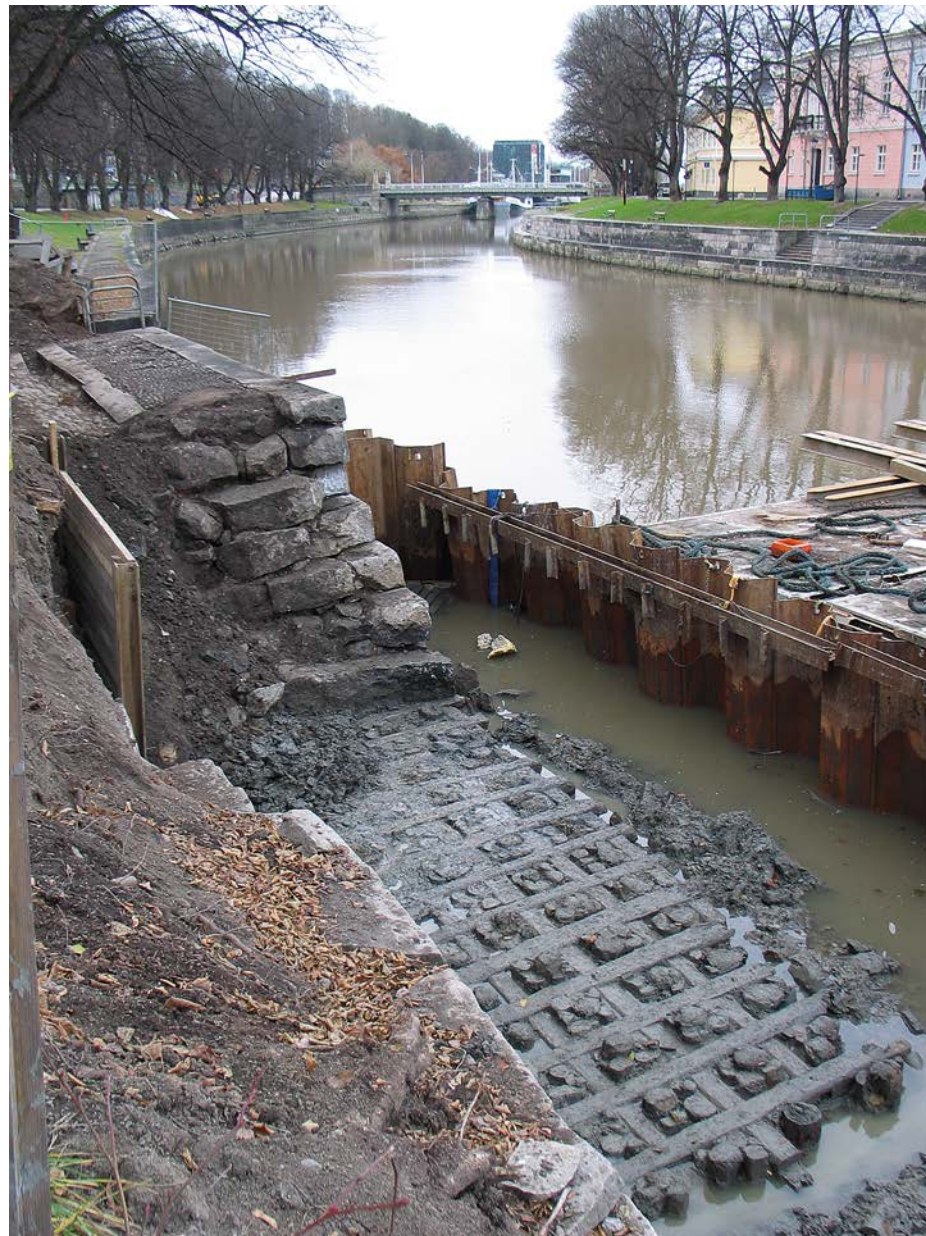
KUVA 2. Nykyisen itälaiturin vanhaa arinaa ja paalutusta ennen korjausta (DT2009:31:1:173:7352). Kuva Turun museokeskus / Elina Saloranta.
