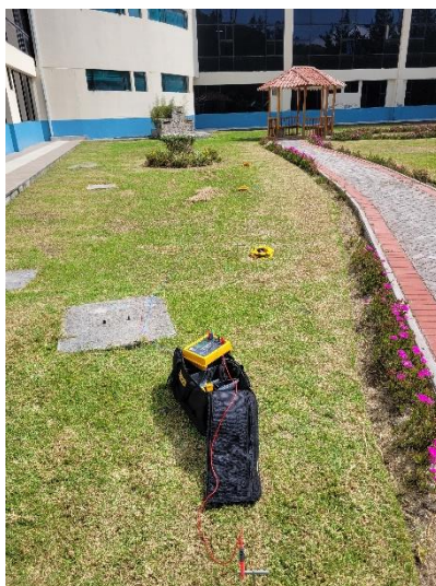
Fig. 44 Medición de puesta a tierra con termómetro Fuente: Autor
