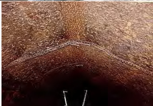
Slika 4: Lokalno izvijanje najverovatnije usled koncentracije opterećenja [27]
