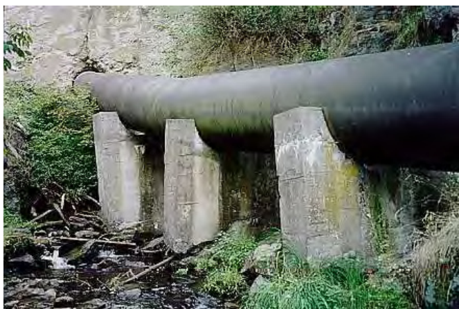
Slika 4: Lokalno izvijanje najverovatnije usled koncentracije opterećenja [27]
