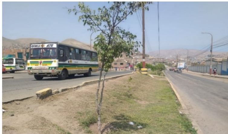
Figura 25: Delimitadores espaciales en mal estado y deficientes
