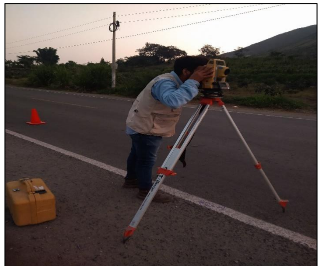
Fotografía: Toma de punto al final del trama La Laguna Km 17.
