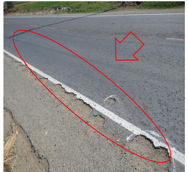
Fotografía: fisura de borde de severidad considerado a lo largo de borde de calzada
