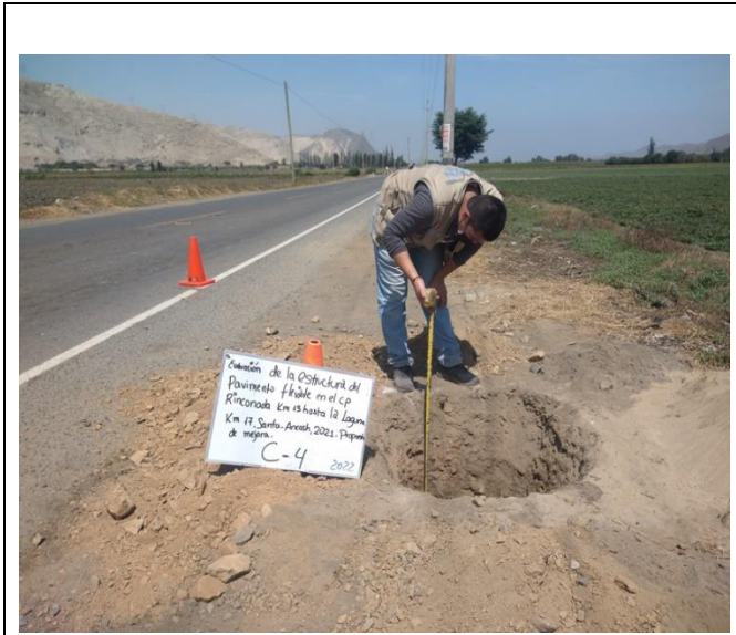
Fotografía: ejecución de calicata 5 para extracción de muestras
