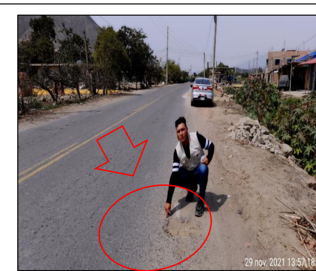
Fotografía: Fallas tipo grietas de borde para
