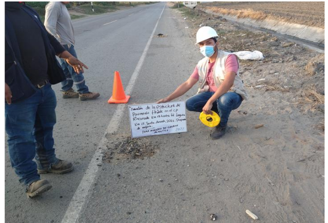
Fotografía: extracción de muestra para ensayo de lavado asfáltico
