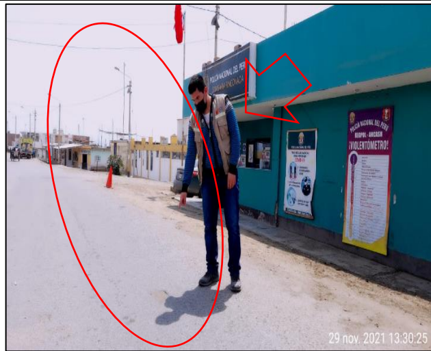
Fotografía: Falla tipo exudación
