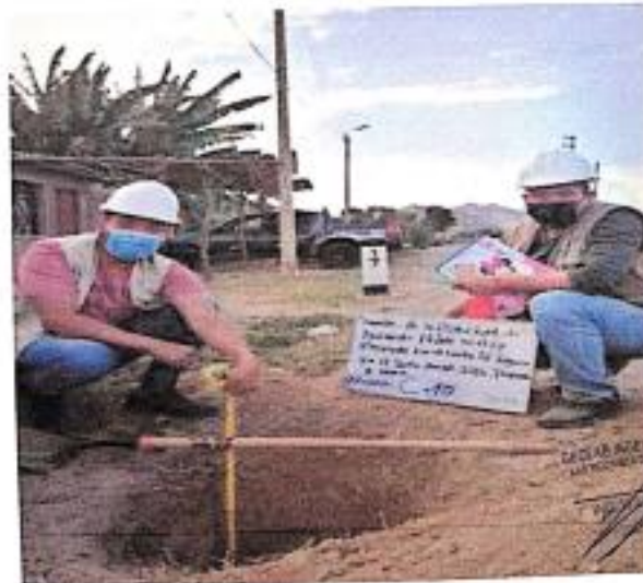
FOTOS ESCAVACION DE CALICATA C-10
