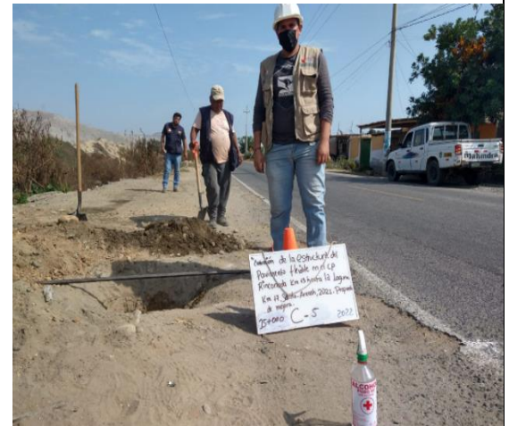
Fotografía: ejecución de calicata 6 para extracción de muestras
