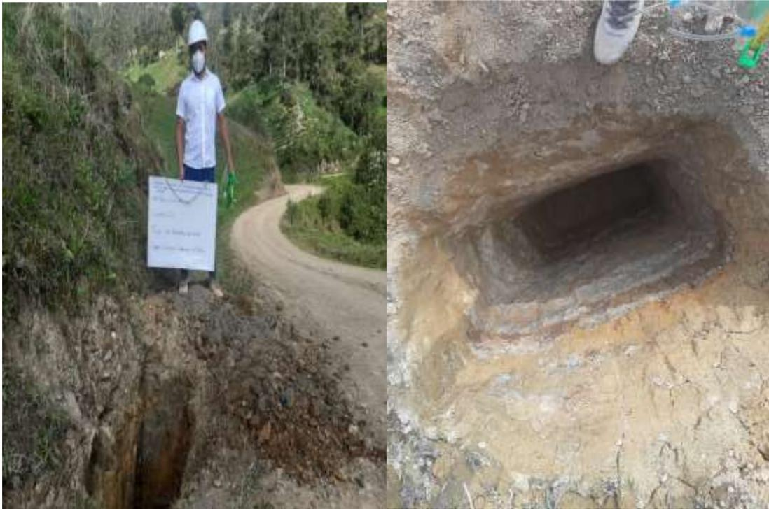
Figura 20: Excavación de calicata - C6
