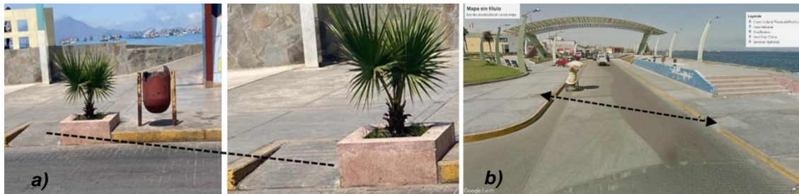
Figura 8: no existe continuidad de rampas
