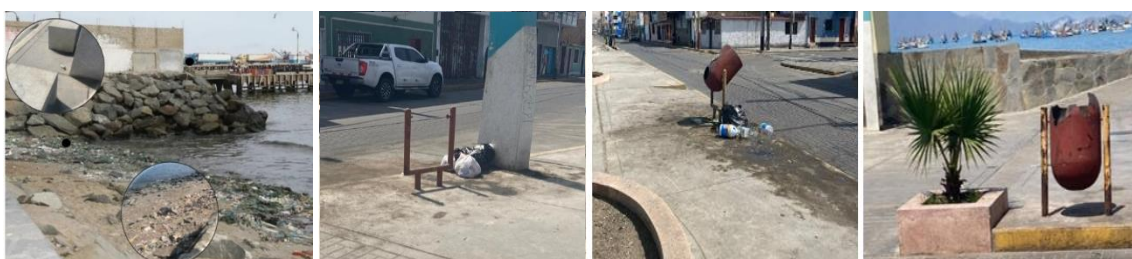
Figura 19: contaminación en enrocado y contenedores deteriorados
