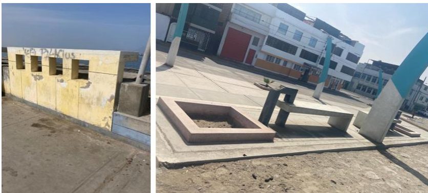
Figura 13::Bancas de concreto armado
