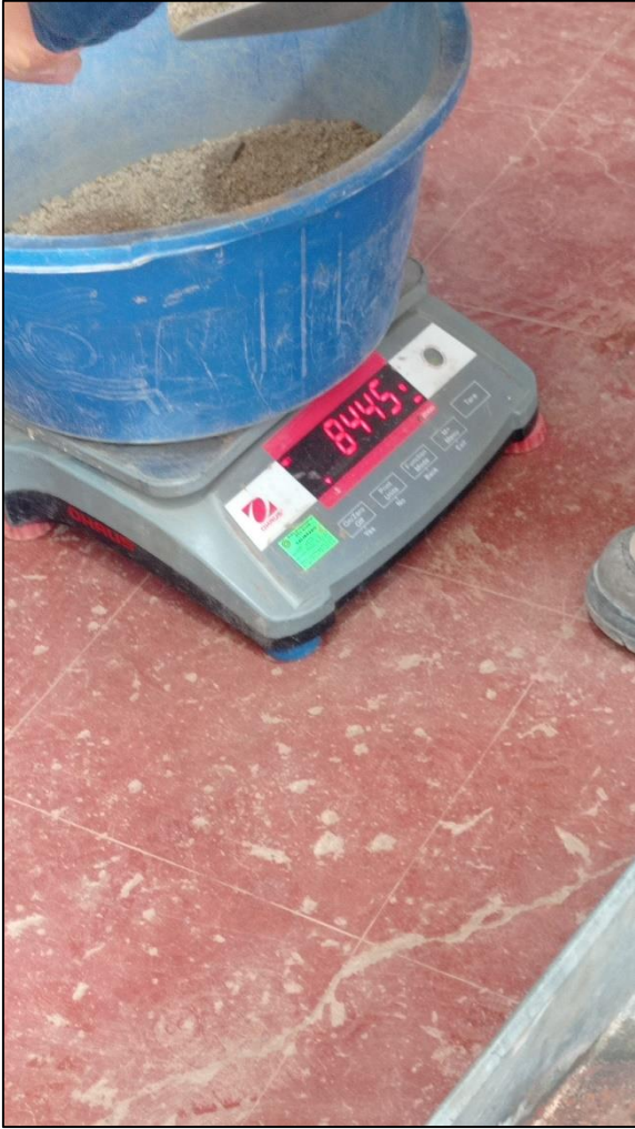
Foto N° 21: Pesaje de materiales para la dosificación
