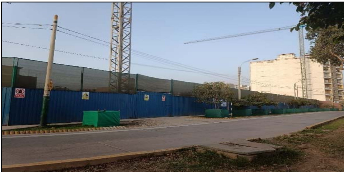
Figura 21: Terreno lado Sur
