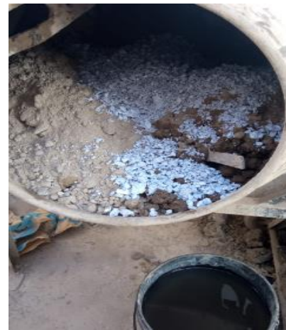
Fotografía N°16: Preparación junto a la mezcladora para el concreto 1% fasteners más (4%, 8% y 12%) con celulosa de papel.
