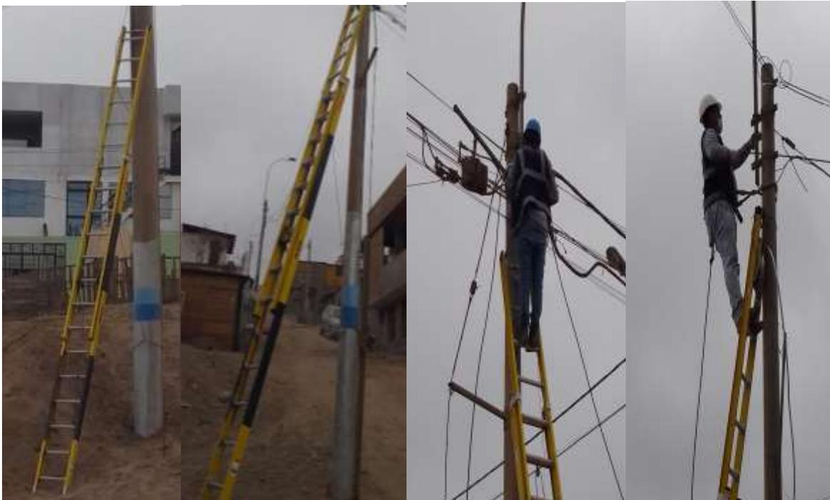
*Figura 36.* Implementación de escaleras para realizar las instalaciones
