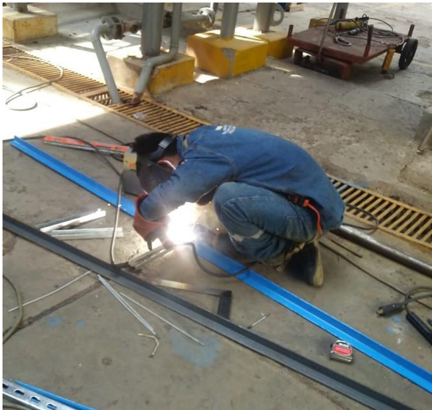
Habilitación de soportaría para alimentación de tablero eléctrico.
