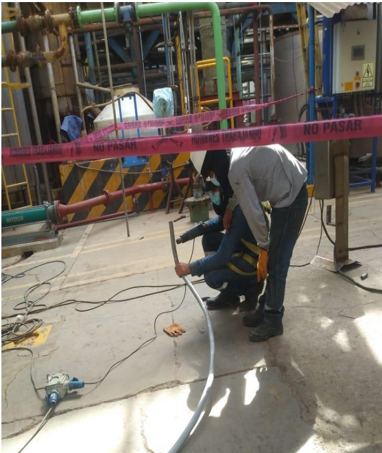
Realizamos bayoneta para el tendido
