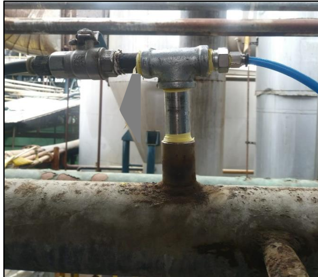
Figura 11. Instalación mecánica del niple, T, con su reducción que llega hacia el FR Fuente: (Elaboración propia)
