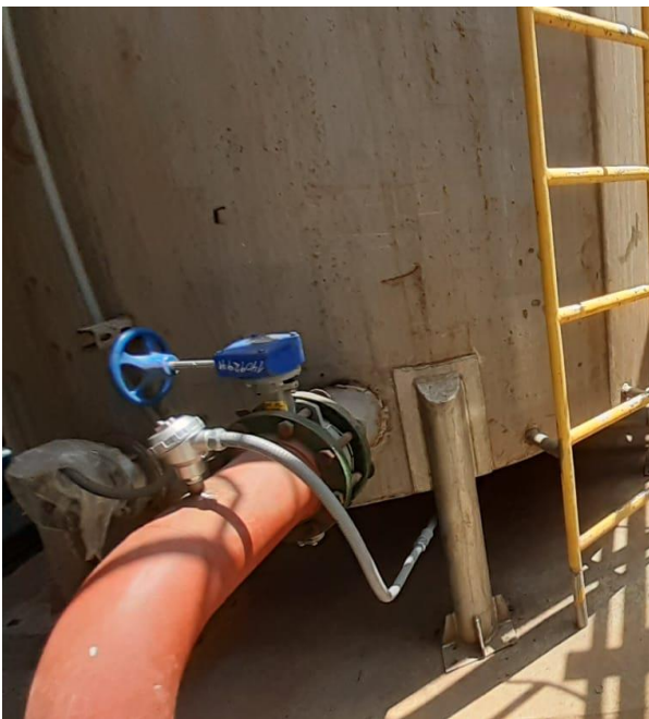
Montaje de soportaría, entubado y tendido de cable para alimentación sensor P100
