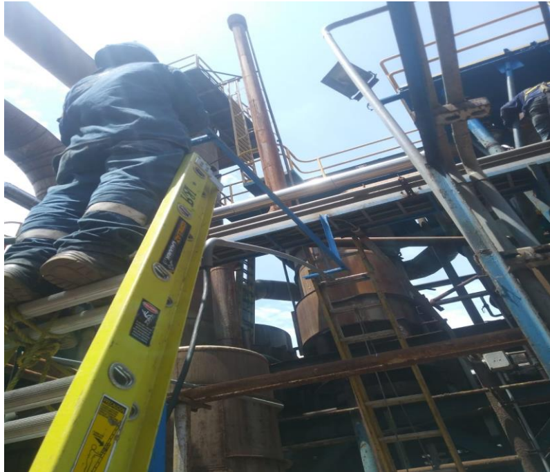
Tendido de tubería PVC-SAP
