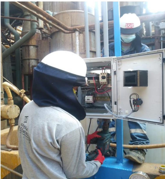
Instalación de tablero eléctrico
