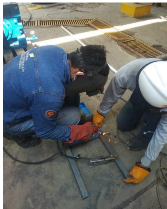
Soldeo de soporte de tablero.
