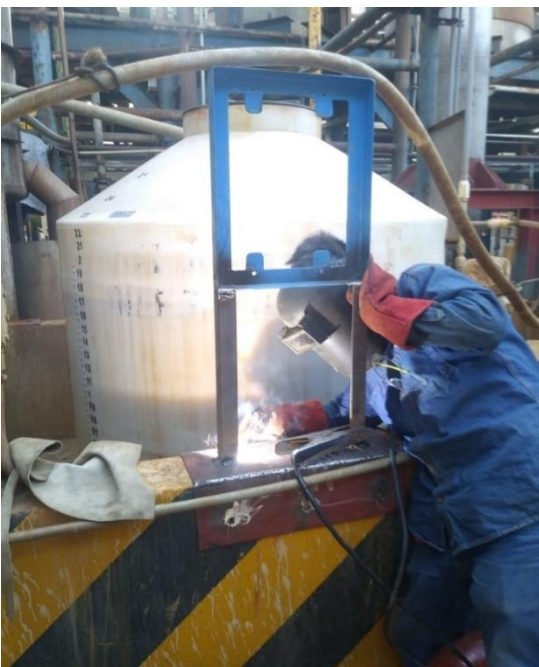
Soldeo y montaje de soporte de tablero
