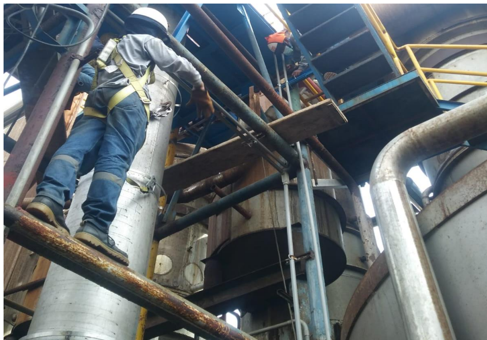
Tendido de tubería PVC-SAP de ¾"
