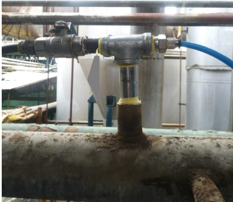
Instalación mecánica del niple, T, con su reducción que llega hacia el FR.
