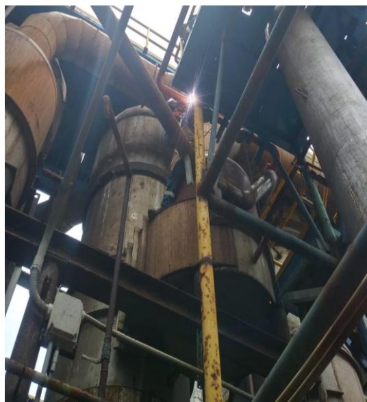
Soldeo de soportaría la salida del posicionador
