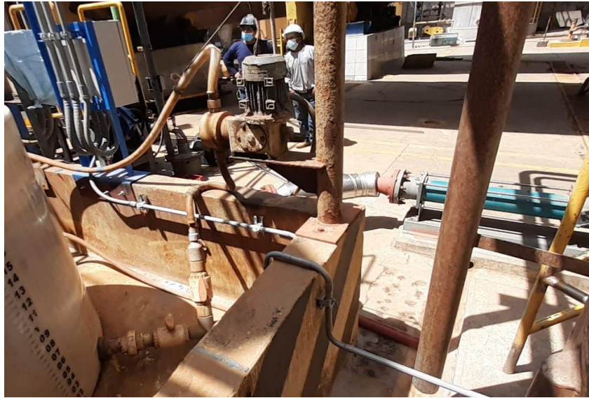
Montaje de soportaría, entubado y tendido de cable para alimentación sensor P100
