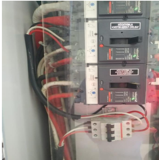
Instalación de llave térmica 3x32A para alimentación del tablero eléctrico
