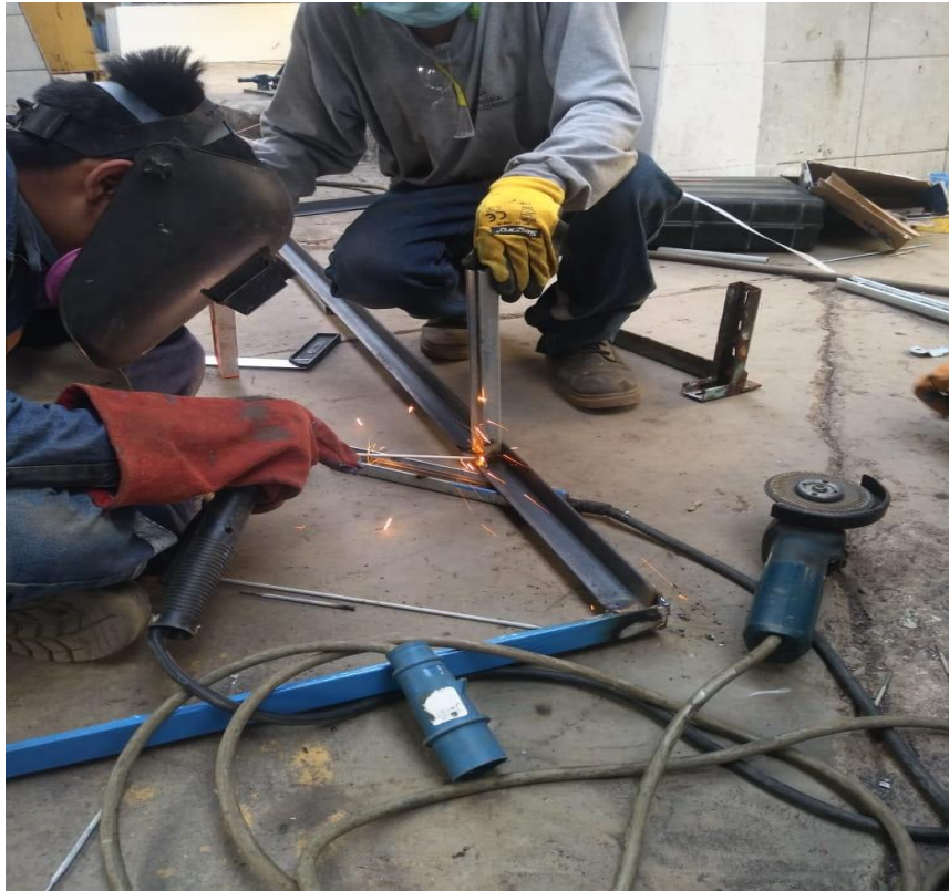
Soldeo de riel unistrunt pesado.
