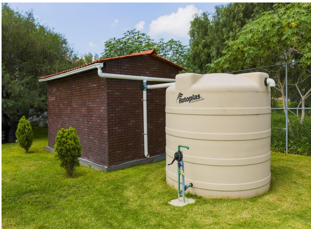
Figura 7 Cisterna de captación independiente doméstico
