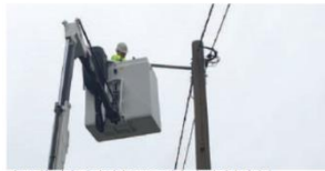
Jaworski trabajando desde la cesta en el alumbrado de la ciudad.
