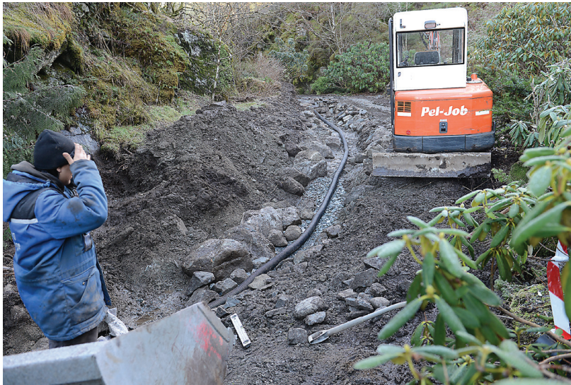
Ny drenering legges langs veien gjennom Tømmermåget (foto: Bjørn Moe 18.02.2014)
