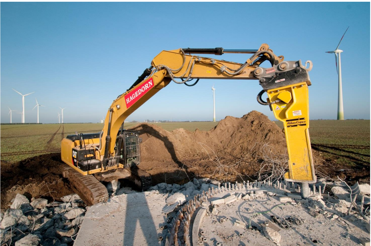
Abbildung 2-4: Fundament-Rückbau. Bild: Hagedorn Unternehmensgruppe
