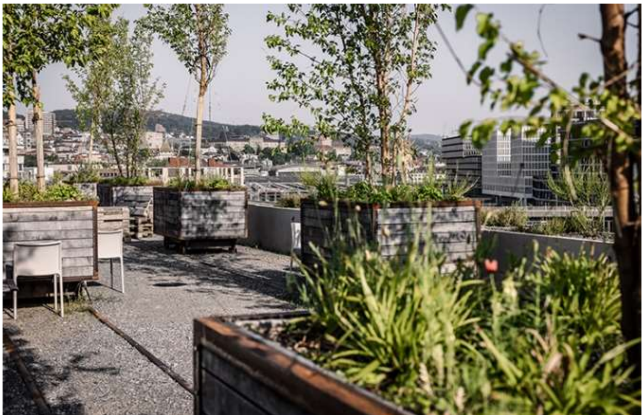
Abbildung 41: Mithilfe mobiler Systeme können Bereiche der Dachbegrünung an die jeweiligen Nutzungsbedürfnisse angepasst werden © Annett Landsmann
