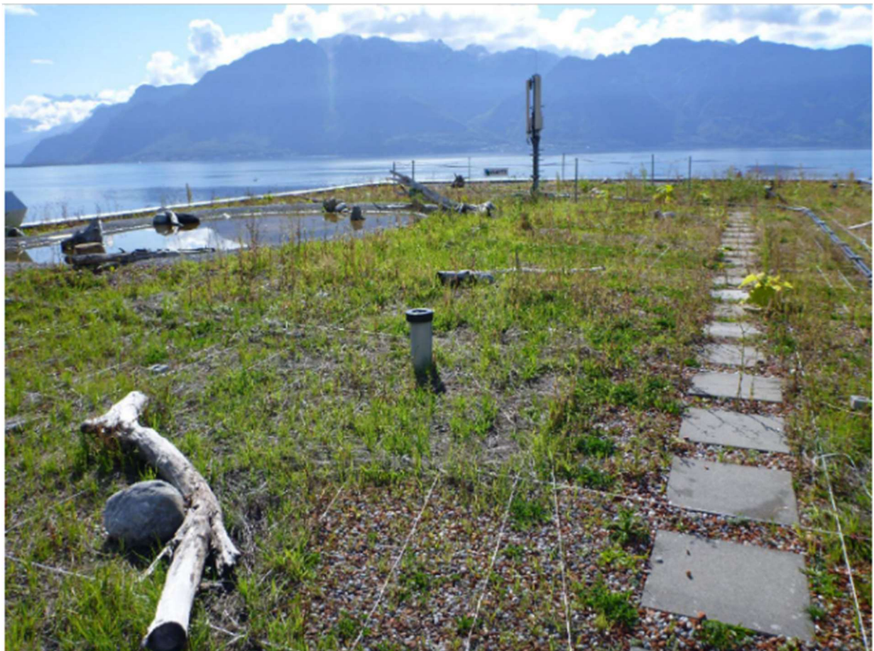
Abbildung 42: Die Dachbegrünung des Schulhauses mit temporären Gewässern und Schnüren zur Sicherung des Mahdgutes © Saskia Godat
