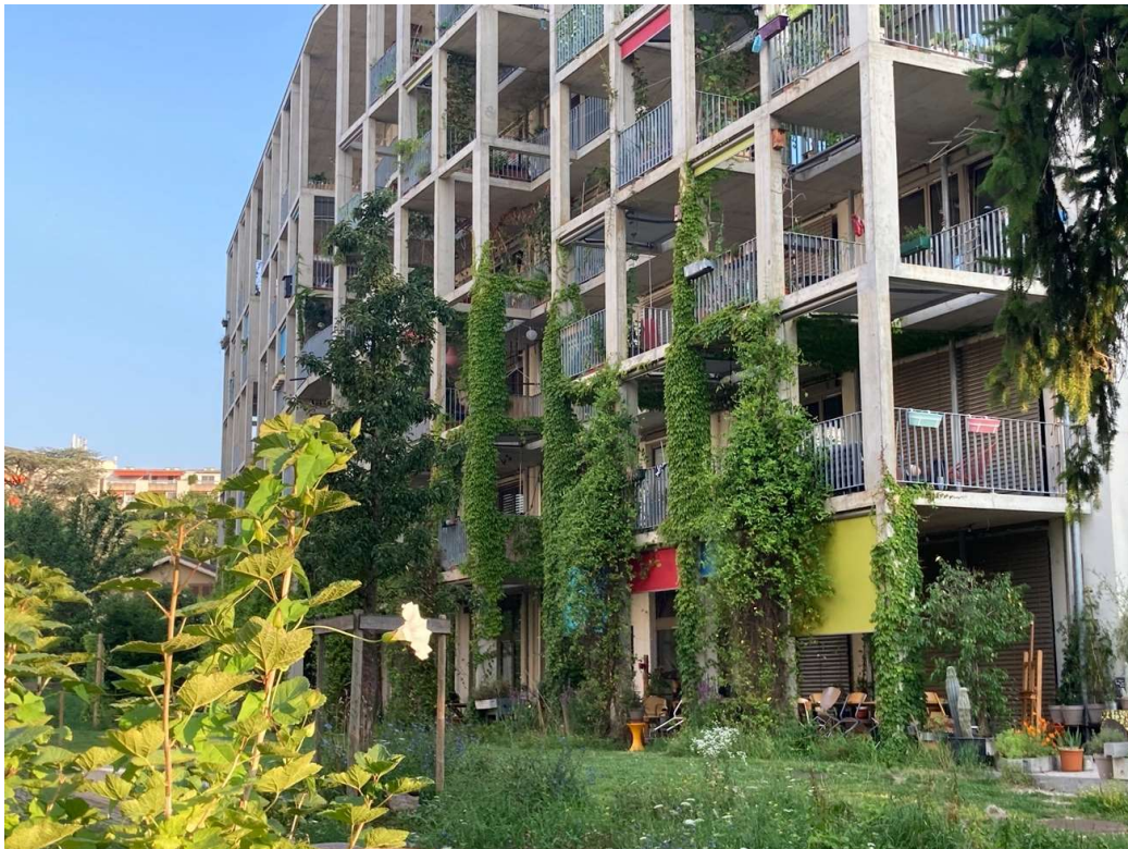
Abbildung 25: Üppiges Grün im Aussenraum und Kletterpflanzen zur Fassadenbegrünung des Gebäudes © Alix Jornot
