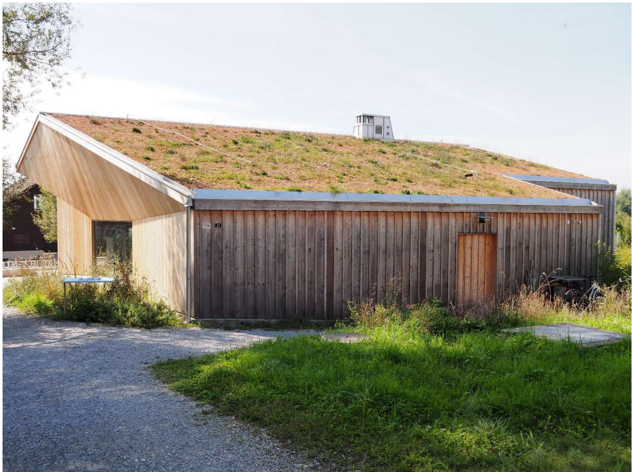
Abbildung 14: Das Naturzentrum Pfäffikon soll die Menschen mit gutem Beispiel und einer ansprechenden Gestaltung von Gebäude und Umschwung zu mehr Biodiversität im privaten Rahmen animieren (Vegetation noch nicht vollständig etabliert)
