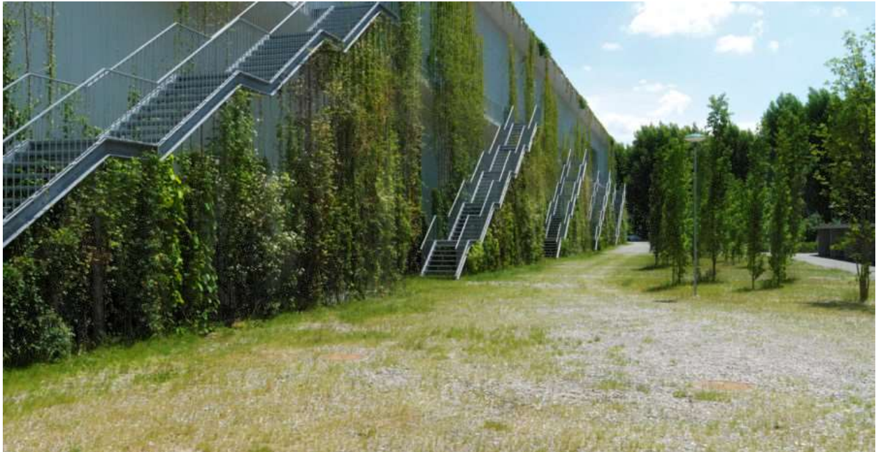
Abbildung 24: Die bodengebundene Fassadenbegrünung wird von Kletterpflanzen ergänzt, welche von der Dachfläche aus nach unten wachsen © GRÜNSTATTGRAU
