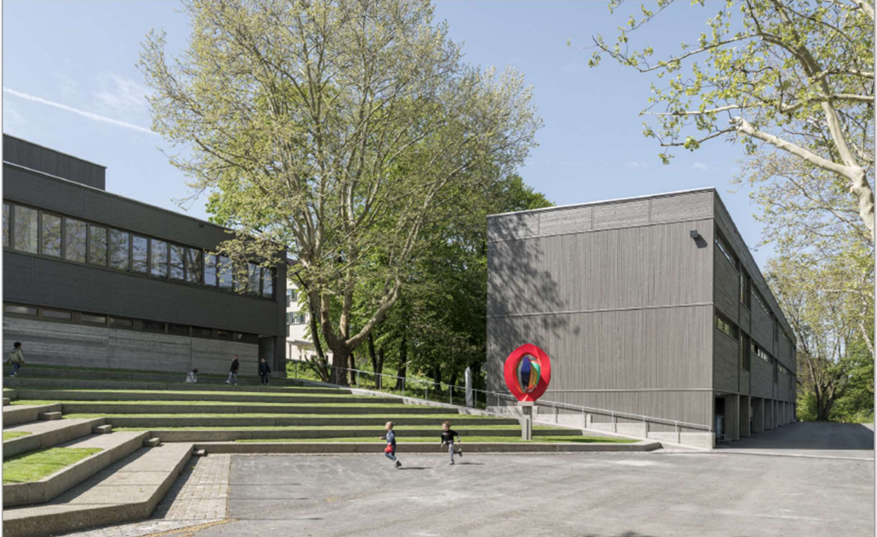
Abbildung 20: Der treppenartige Pausenhof der Schulanlage Looren vermittelt zwischen Architektur und der unter Denkmalschutz stehenden Aussenanlage © Stadt Zürich, Amt für Hochbauten
