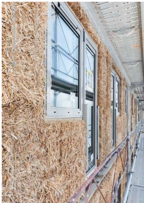
Abbildung 28: Die Nachhaltigkeit steht auch beim Gebäude selbst im Vordergrund: die Fassadenisolation besteht aus Strohballen und Lehm © Annik Wetter, Julien Germaud
