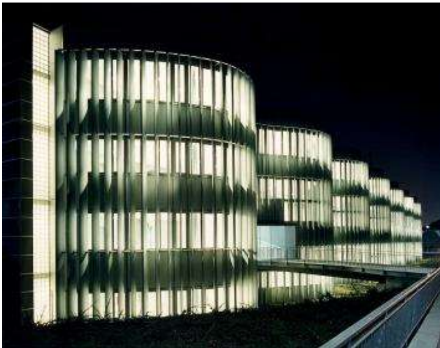
Abbildung 45: Das ehemalige Swisscom Service Center wurde als Pilotprojekt im energetischen und ökologischen Gebäudebau genutzt © Franco Mattei
