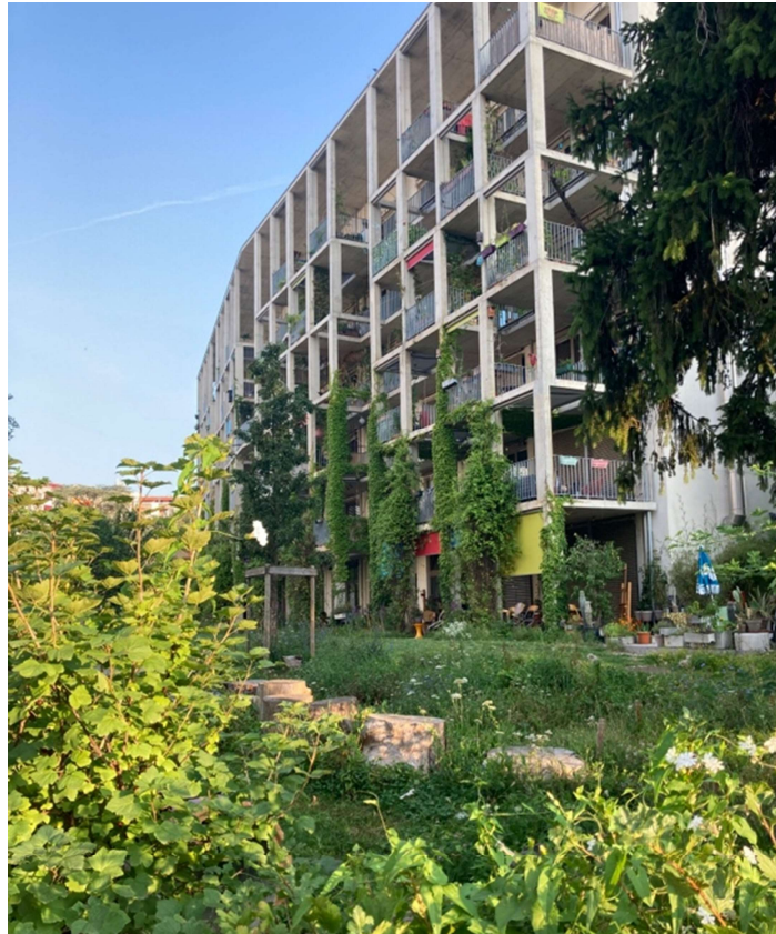
Abbildung 26: Auffallend ist die üppige biodiverse Begrünung auf dem Areal sowie der geringe Versiegelungsgrad im Aussenraum © Alix Jornot
