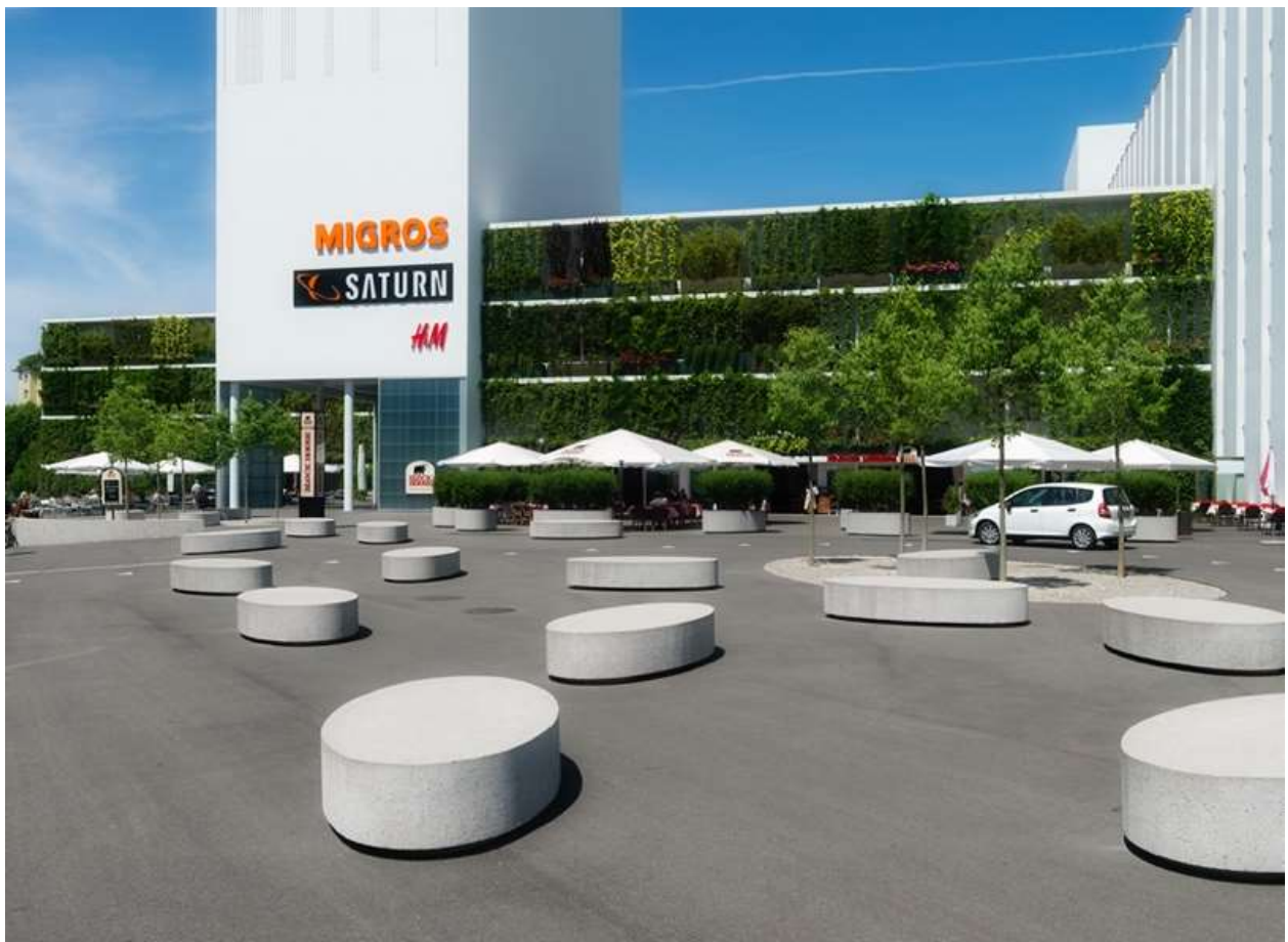
Abbildung 23: Mit seiner boden- und fassadengebundenen Vertikalbegrünung erscheint das Einkaufszentrum Stücki in Basel als grüne Oase im Gewerbegebiet © Fahrni und Breitenfeld GmbH
