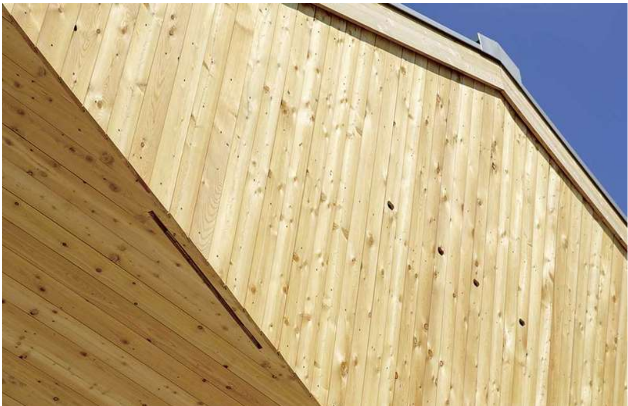
Abbildung 17: Durch die Löcher und Schlitzze in der Holzfassade gelangen Mauersegler resp. Fledermäuse in die Nisthilfen © holzbau-schweiz
