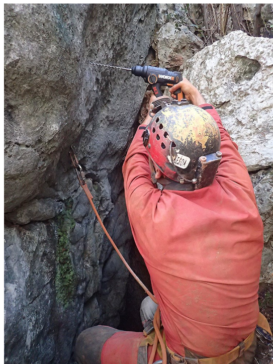
Figura 5-6: Equipagem de algar, com implantação de pernos de ancoragem, Inv. 0056, Olhão. MJP 08/12/2018.
