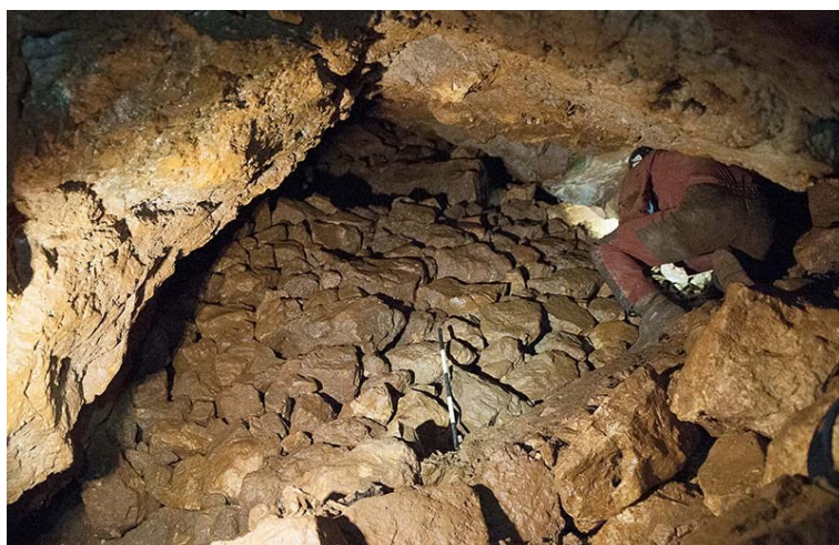
Figura 6-82: Estrutura de tubos metálicos para contenção de pedras soltas no interior da gruta (em cima) e parede de pedras justapostas no troço final da galeria de acesso à sala grande (10/09/2017).
