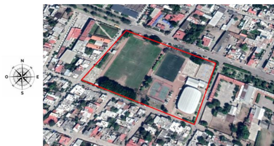
FIGURA 4 Vista aérea del Complejo del Domo Municipal de El Grullo, Jalisco. Fuente: Elaboración propia con base en Google Earth.
