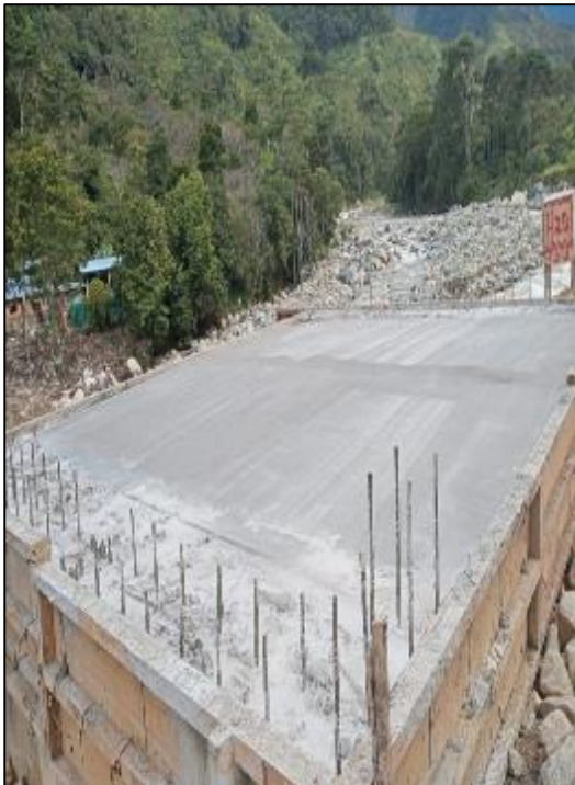
23 DE DICIEMBRE DEL 2020: Se realiza los trabajos de colocado de concreto f'c=280 kg/cm 2 en losa de aproximación de estribo derecho.
