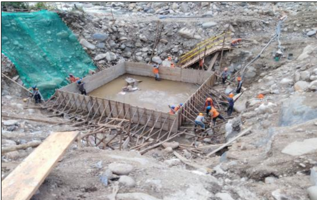
12 DE NOVIEMBRE DEL 2020: Se realiza los trabajos de encofrado de zapata de estribo derecho.
