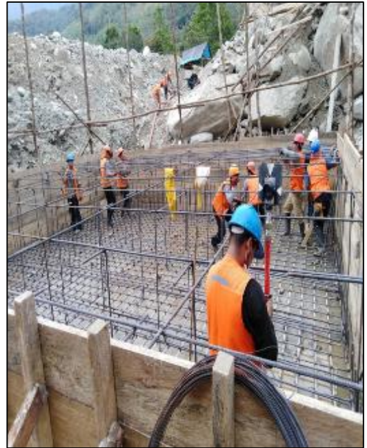
27 DE OCTUBRE DEL 2020: Se realiza los trabajos de colocado de acero corrugado grado 60 en zapata izquierda.
