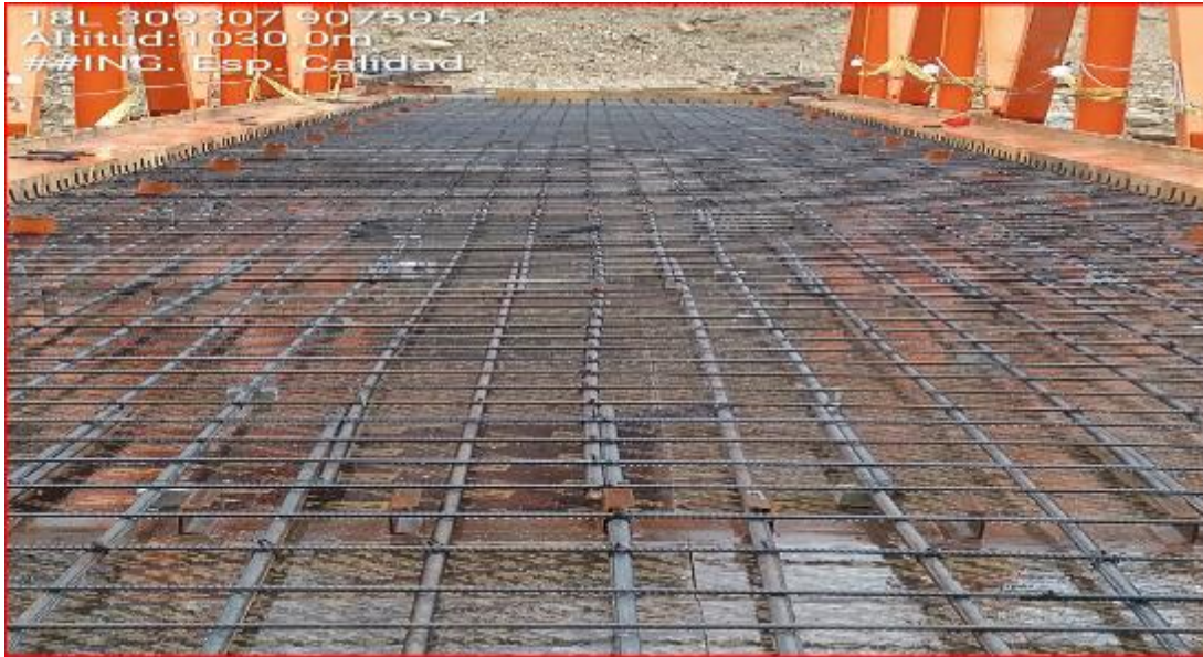
26 DE ABRIL DEL 2021: Se observa los trabajos de colocado de acero de refuerzo grado 60 y tuberías de drenaje, en losa maciza de puente vehicular.
