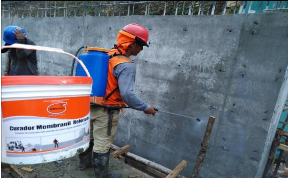
11 DE NOVIEMBRE DEL 2020: Se realiza los trabajos curado de concreto en estribo izquierdo.
