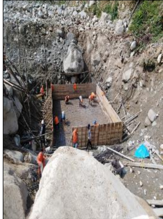
26 DE OCTUBRE DEL 2020: Inicia con los trabajos encofrado de zapata izquierda.
