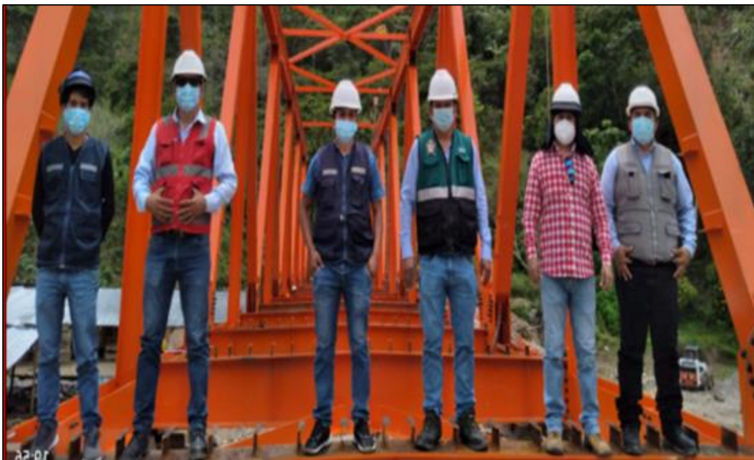
20 DE MARZO DEL 2021: Se observa el colocado de los elementos metálicos con pernos a-326, con un avance físico del 90% aproximadamente.
