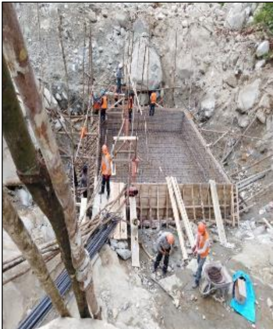
27 DE OCTUBRE DEL 2020: Se realiza los trabajos de colocado de acero corrugado grado 60 en zapata izquierda.
