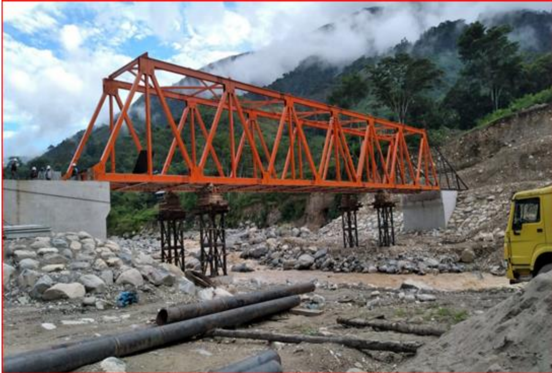
22 DE ABRIL DEL 2021: Se observa los trabajos de lanzamiento de puente metálico vehicular, en su posición final.
