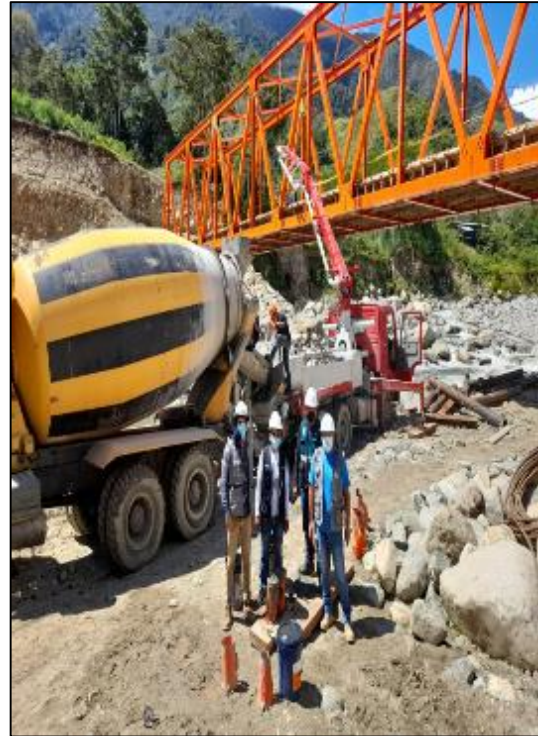
30 DE ABRIL DEL 2021: Se observa los trabajos de colocación de concreto 280 \text{ kg/cm}^2 en losa maciza.
