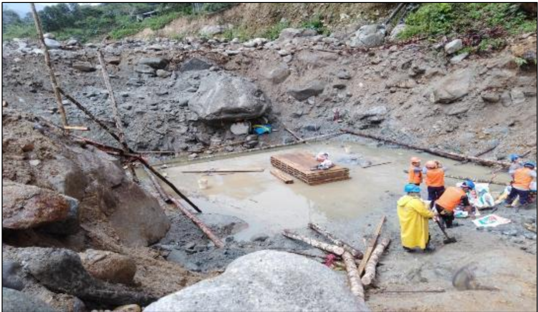
25 DE OCTUBRE DEL 2020: Inicia con los trabajos colocado de concreto f'c=100 \text{ kg/cm}^2 en solados e=20\text{cm} , en zapata izquierda.
