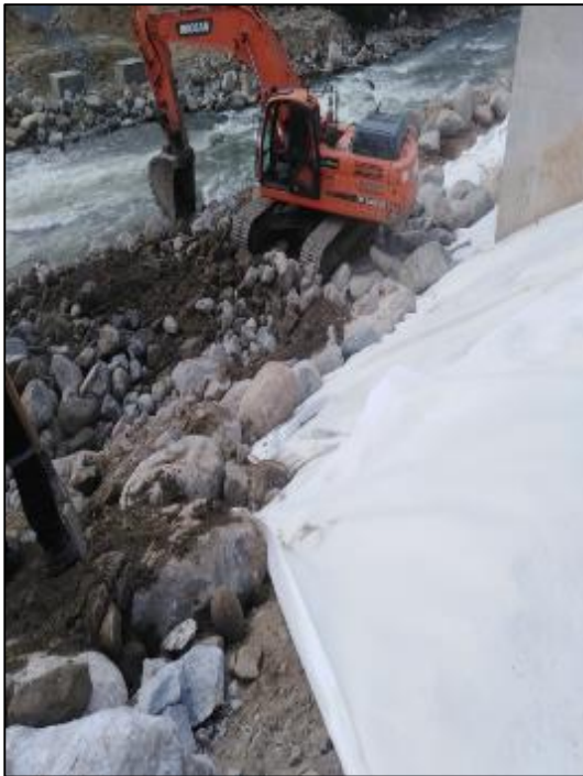
17 DE FEBRERO DEL 2021: Se realiza los trabajos de colocado de rocas d > 0.80m , para enrocado de margen derecho del rio Tocache
