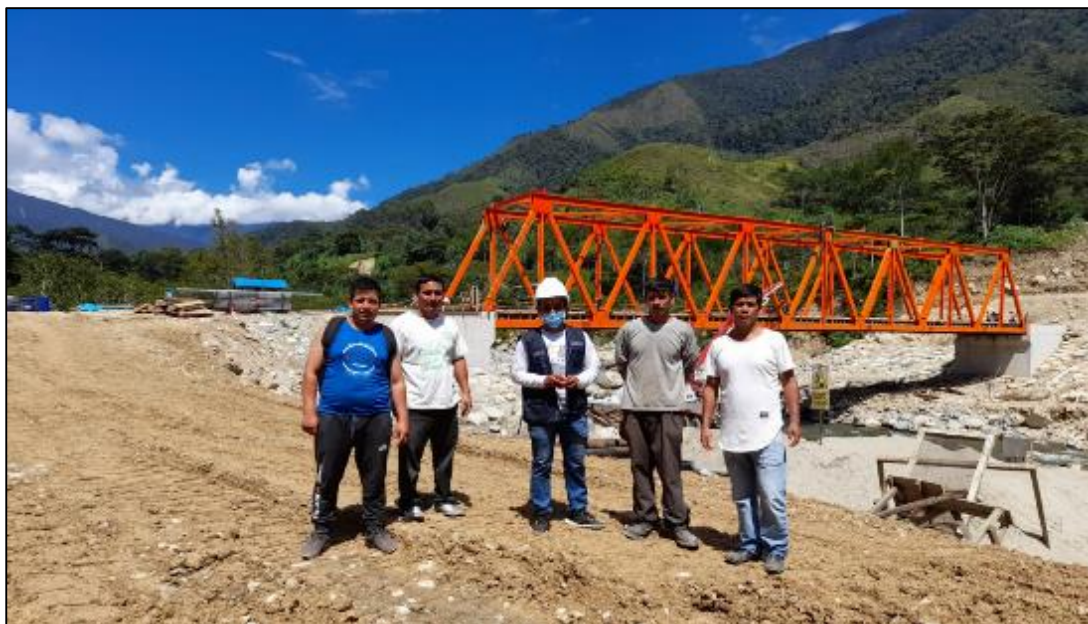
22 DE ABRIL DEL 2021: se observa los trabajos de lanzamiento de puente metálico vehicular, en su posición final.
