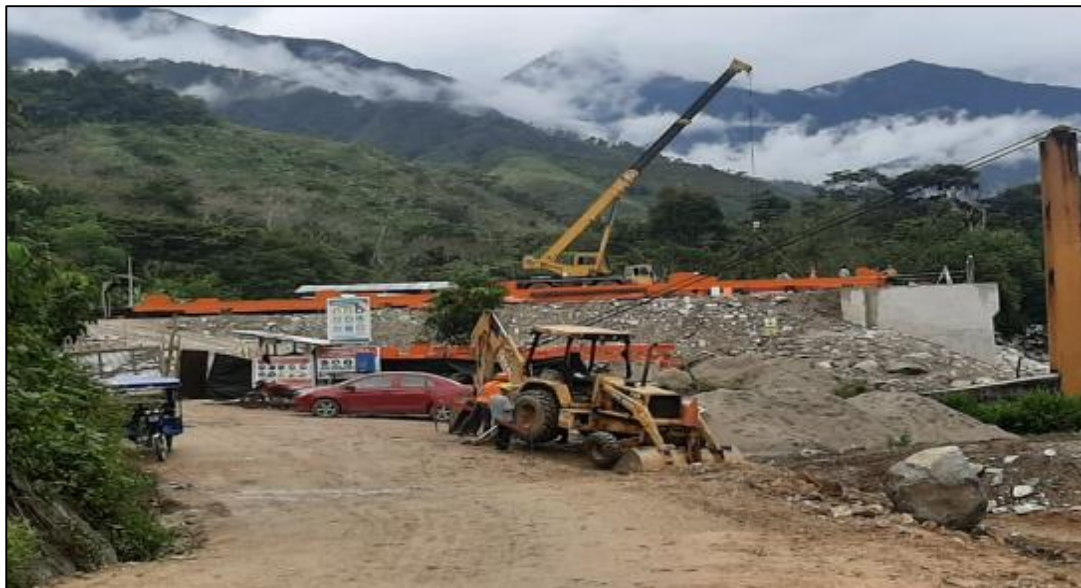
26 DE FEBRERO DEL 2021: Continúan los trabajos de montaje de estructura metálica del puente.
