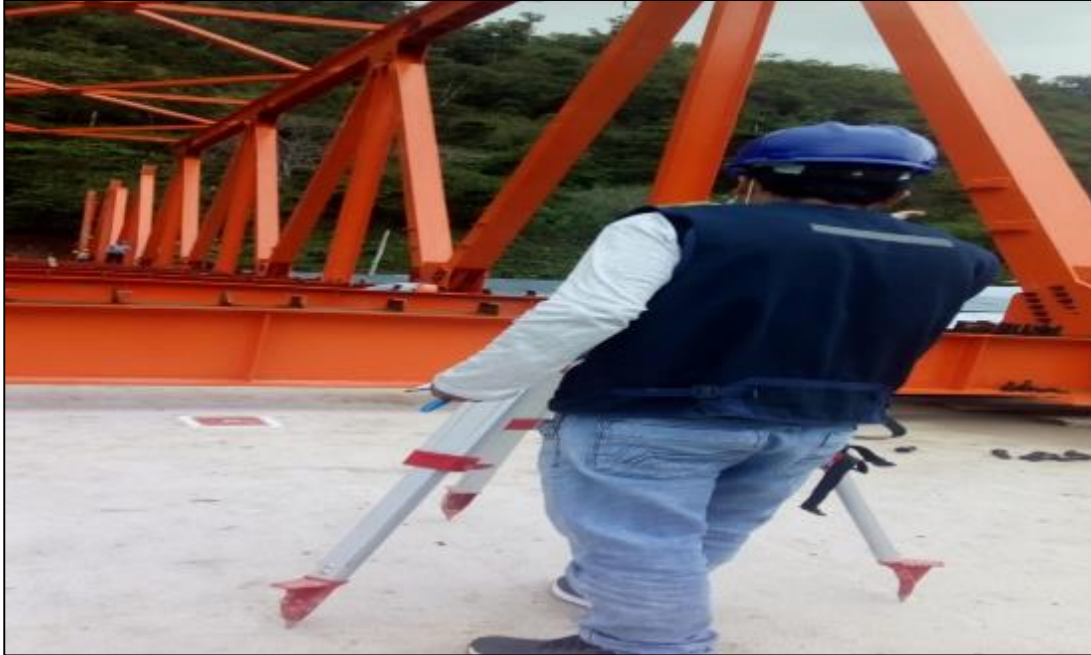
15 DE MARZO DEL 2021: Se observa el control de la contra flecha, en los trabajos de montaje
