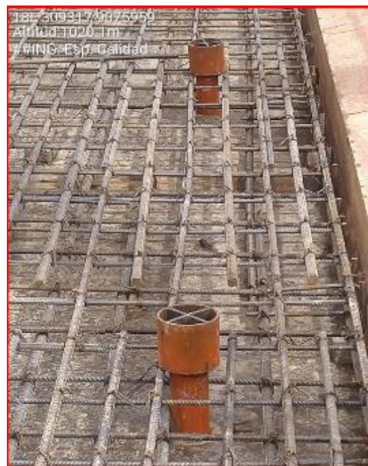
26 DE ABRIL DEL 2021: Se observa los trabajos de colocado de acero de refuerzo grado 60 y tuberías de drenaje, en losa maciza de puente vehicular.
