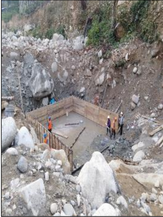
26 DE OCTUBRE DEL 2020: Inicia con los trabajos encofrado de zapata izquierda.
