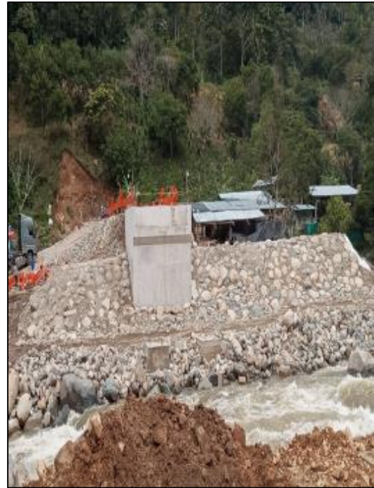
17 DE FEBRERO DEL 2021: Se realiza los trabajos de colocado de rocas d > 0.80m , para enrocado de margen derecho del rio Tocache
