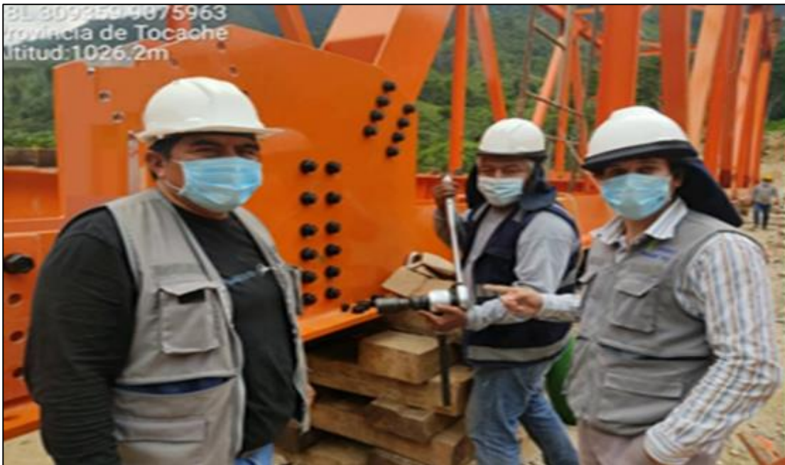
12 DE MARZO DEL 2021: Continúan los trabajos de montaje de estructura metálica del puente, control de torque en los pernos, de acuerdo al plan de montaje y lanzamiento .
