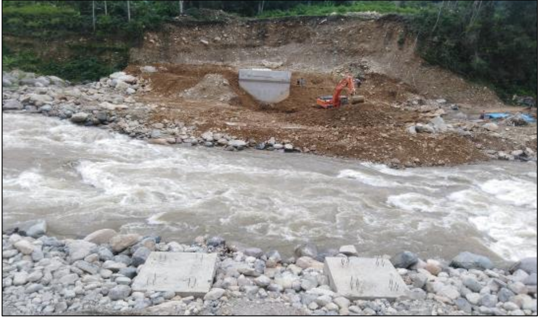
24 DE FEBRERO DEL 2021: Se realiza los trabajos de perfilado y excavación de cimentación de enrocado margen izquierdo del rio Tocache.
