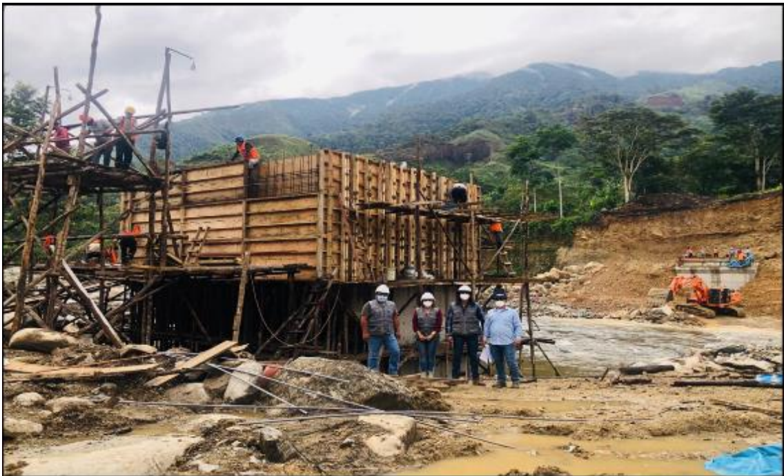
12 DE DICIEMBRE DEL 2020: Se realiza los trabajos de encofrado en pantalla de estribo derecho, CUARTO NIVEL.
