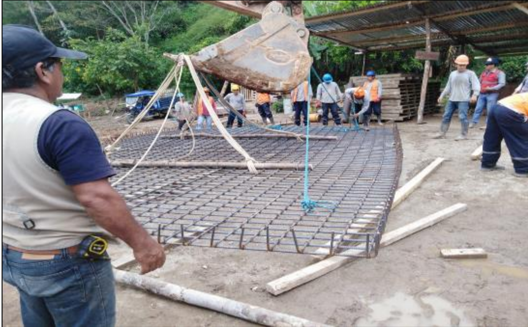
19 DE DICIEMBRE DEL 2020: Se realiza los trabajos de habilitación de acero de refuerzo en losa de aproximación del estribo margen derecho
