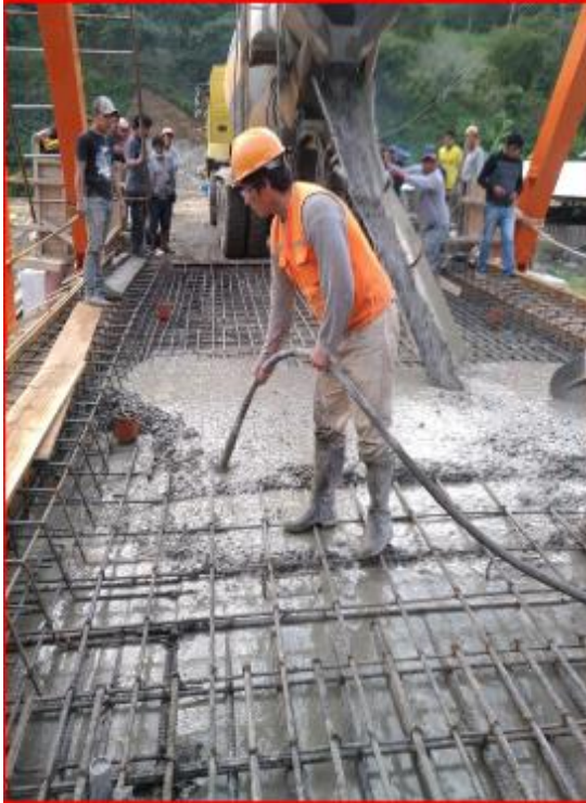
30 DE ABRIL DEL 2021: Se observa los trabajos de colocación de concreto 280 \text{ kg/cm}^2 en losa maciza.
