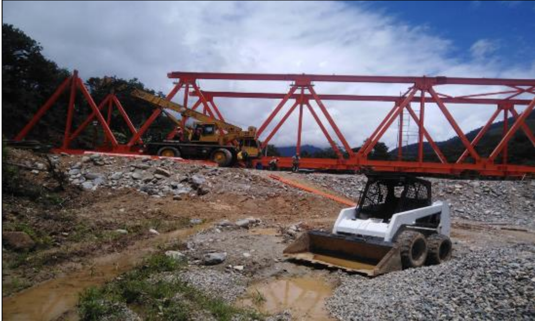
10 DE MARZO DEL 2021: Continúan los trabajos de montaje de estructura metálica del puente, colocación de elementos superiores .
