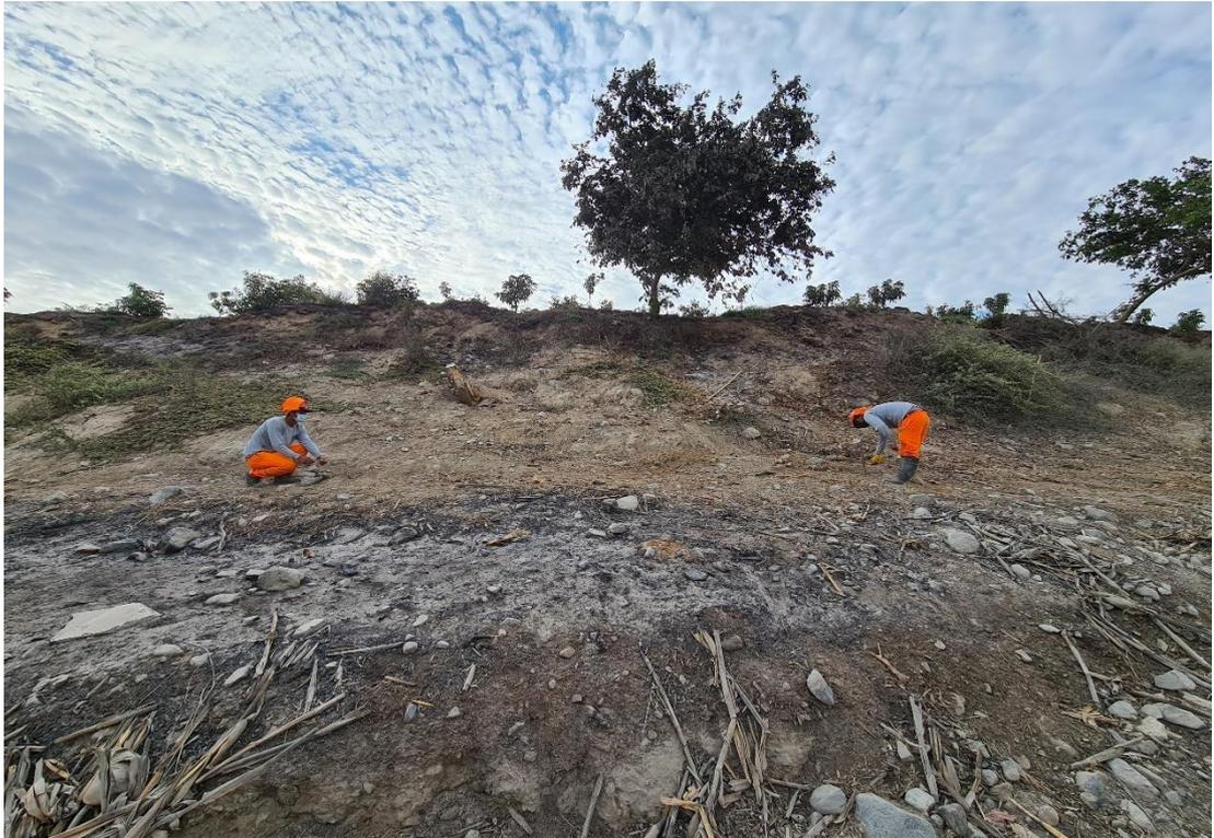
Diseño de surcos según curva de nivel del talud.
