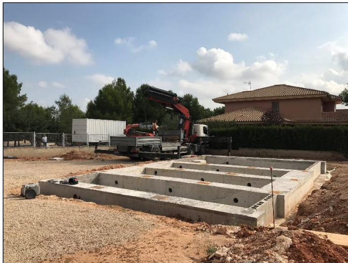
Figura 7 Vigas continuas de cimentación previo ensamblaje de caseta modular Tomado de Tres60 arquitectura. Imágenes propias de archivo de proyectos desarrollados en el estudio (Fuente: Perez, 2021).
