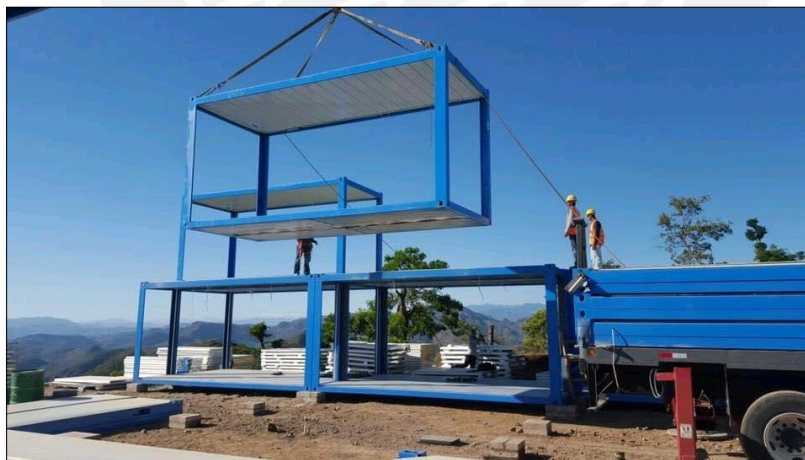
Figura 68 Izaje de módulos Flat Pack en campo
