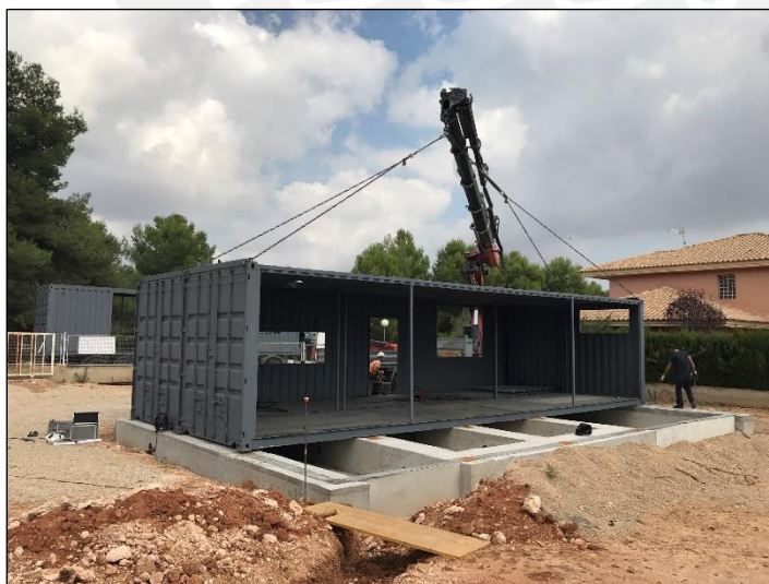
Figura 8 Vigas continuas de cimentación ensambladas a caseta modular Tomado de Tres60 arquitectura. Imágenes propias de archivo de proyectos desarrollados en el estudio (Fuente: Perez, 2021).
