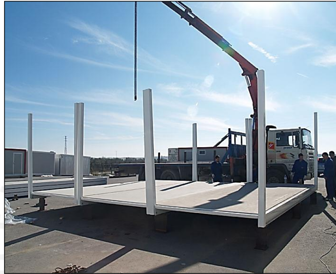
Figura 69 Levantamiento de soportes verticales para ensamblaje de techo Tomado de Alquimodul – Perú (2017). Módulos en Flat Pack (Fuente: Alquimodul, 2017a).
