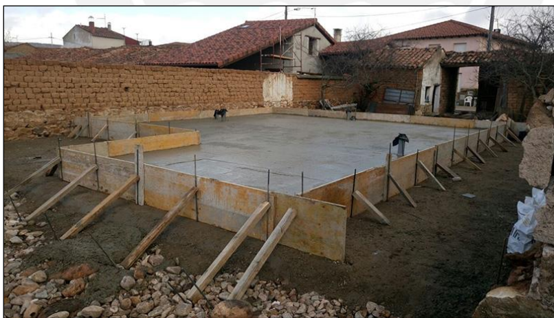
Figura 42 Losa de cimentación en vivienda prefabricada
