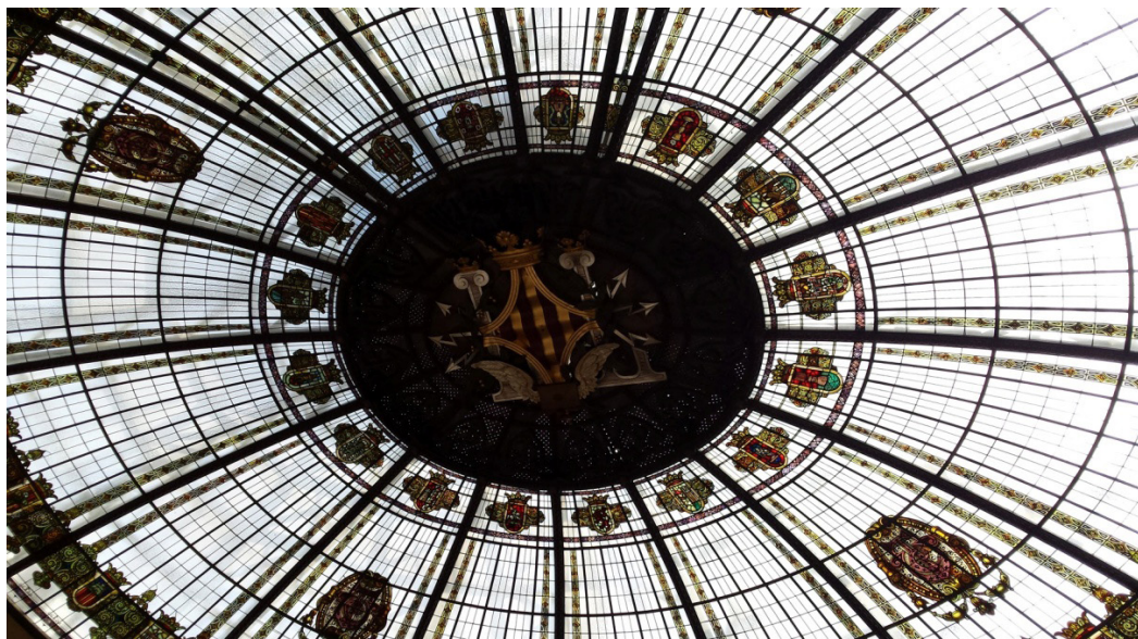
Figura 4. Cúpula de hierro y vidrio del edificio de Correos, de 1914, en Valencia. Fuente propia de los autores.
