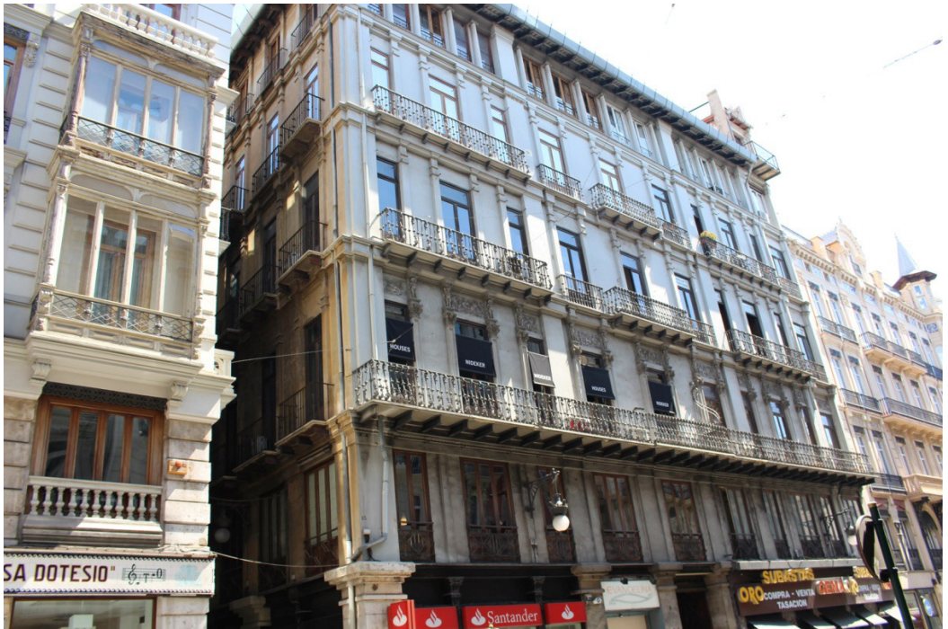
Figura 2. Voladizos resueltos con perfiles de acero laminado. José Camaña, de 1907. Calle de la Paz 17, en Valencia. Fuente propia de los autores.
