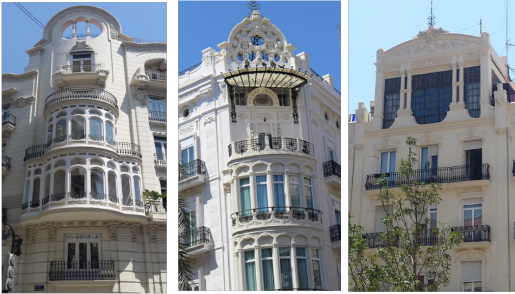
Figura 5. Mirador del edificio Chapa en G.V. Marqués del Turia 65, de Carlos Carbonell, en 1916, Valencia (izda.). Ático con fachada de hierro y vidrio en Cirilo Amorós 66, de Francisco Almenar, en 1915, Valencia (centro). Marquesina sobre mirador en Pérez Pujol 2, de Luis Ferreres, en 1910, Valencia (dcha.). Fuente propia de los autores.
