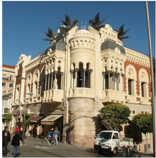
Figura 7. Casa de los Dragones de Ceuta (1900-1905). Arquitecto: J. M a . M. Cortina.
