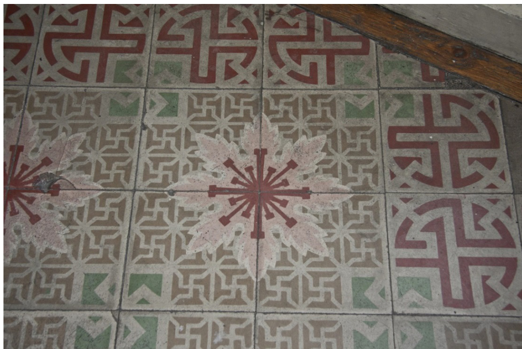
Figura 3. Detalle del pavimento hidráulico del Salón Chaflán del Museo Cerralbo. Nº Inv. 29076, 1891-93.
