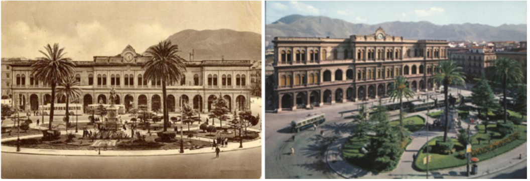
Figure 10a y 10b. La Estación Central antes y después de la elevación.
