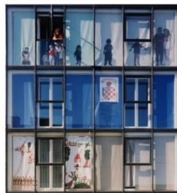
Vistas exteriores del edificio.
