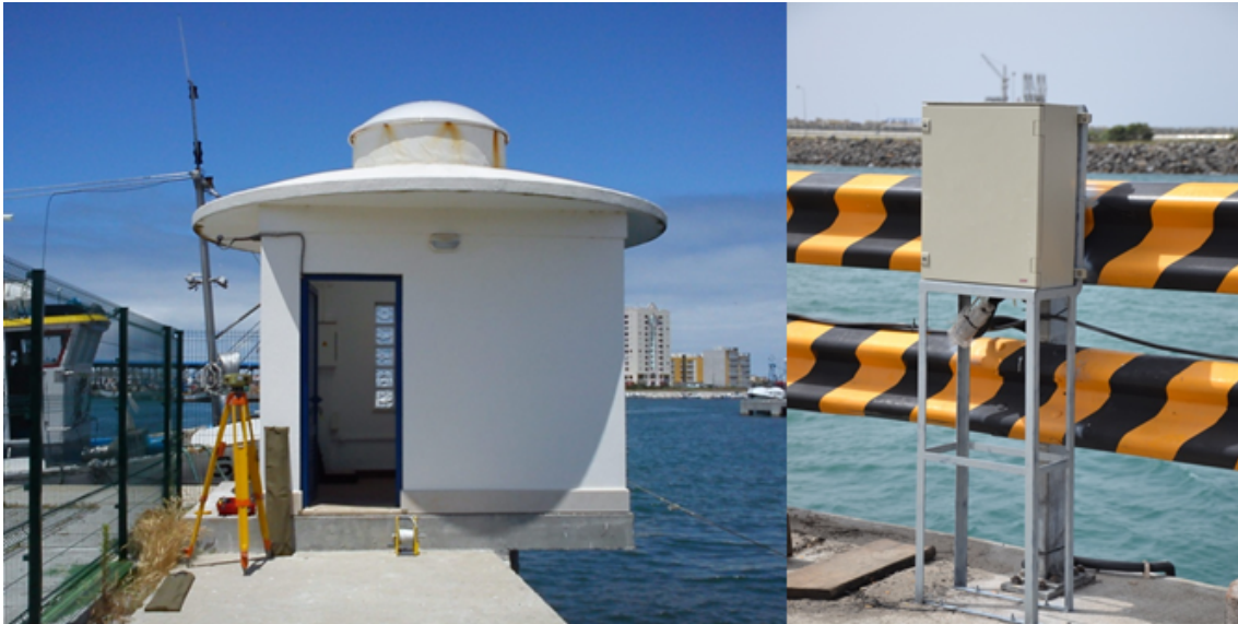
FIGURA 2.1: Estação maregráfica permanente em Peniche (esquerda); Estação maregráfica de campanha Terminal XXI - Sines (direita) (Fonte: Imagens cedidas pela Divisão de Oceanografia do IH)
