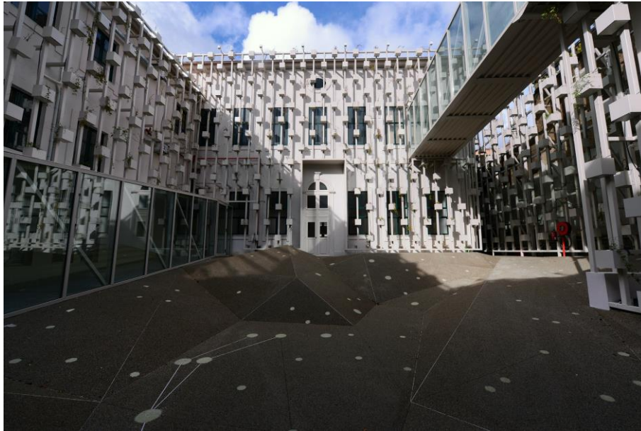
Figura 17. Pátio no Interior do quartel da GNR, atual GNRation Fonte: ( https://dstsa.pt/portfolio/gnracion/ )
