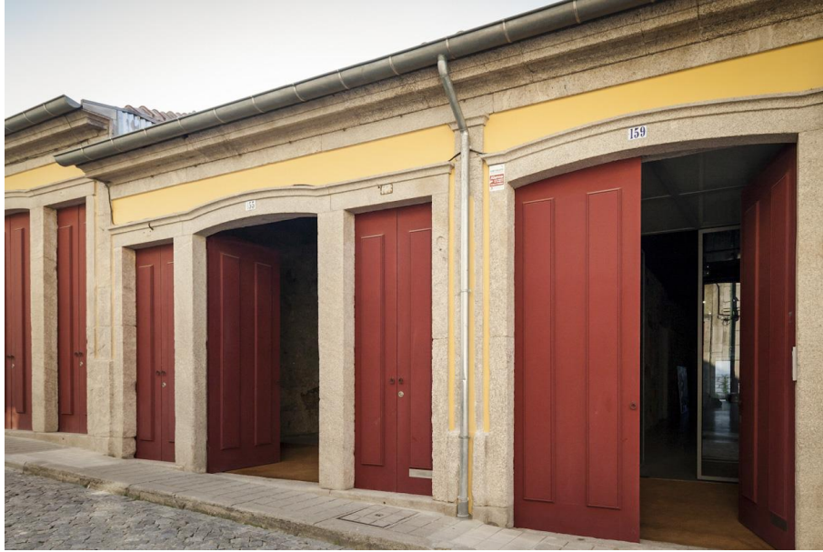
Figura 13. Exterior dos armazéns do Espaço Mira na cidade do Porto Fonte: ( https://miragaleras.net/sobre-nos/ )
