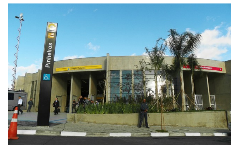
Figura 74: Mezanine superior de transferencia de la estación Pinheiros.
