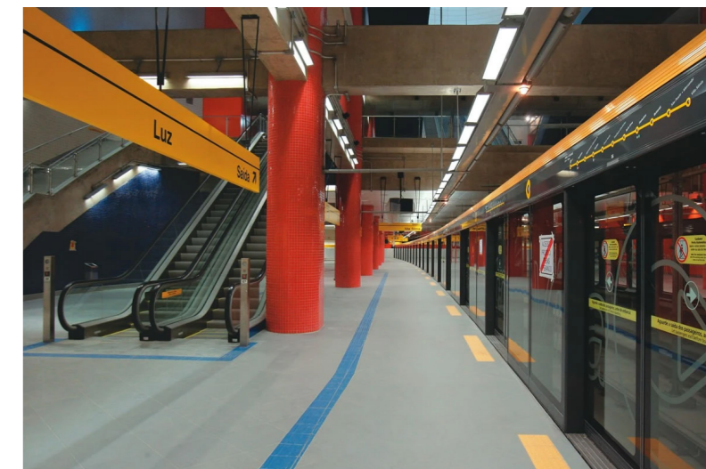
Figura 27: Interior de la estación Luz de tren. Figura 28: Mezanine de la estación Luz de la L1 Figura 29: Andén de la estación Luz de la L4 Fuente: Fotografías de la autora.
