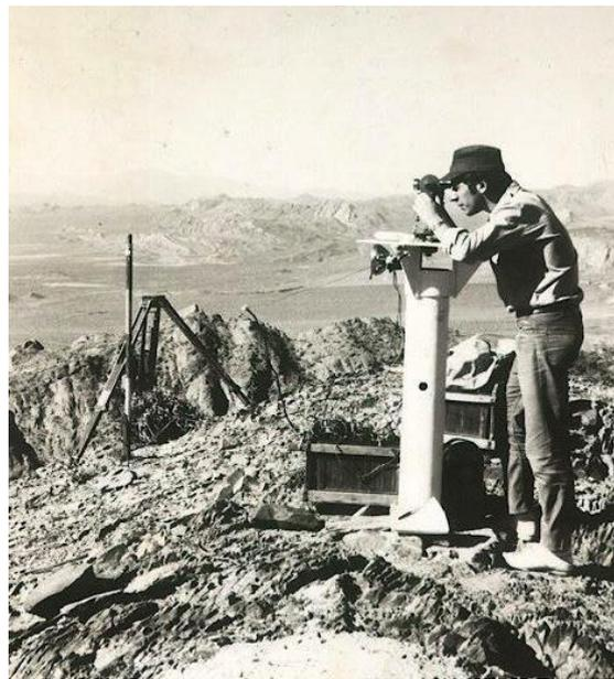
El fundamento de esta nivelación consiste en dirigir visuales a puntos, cuya cota se desea determinar, sobre los cuales se colocan señales, cuya altura ( $S_n$ ) es dato (Figura 5.7).
