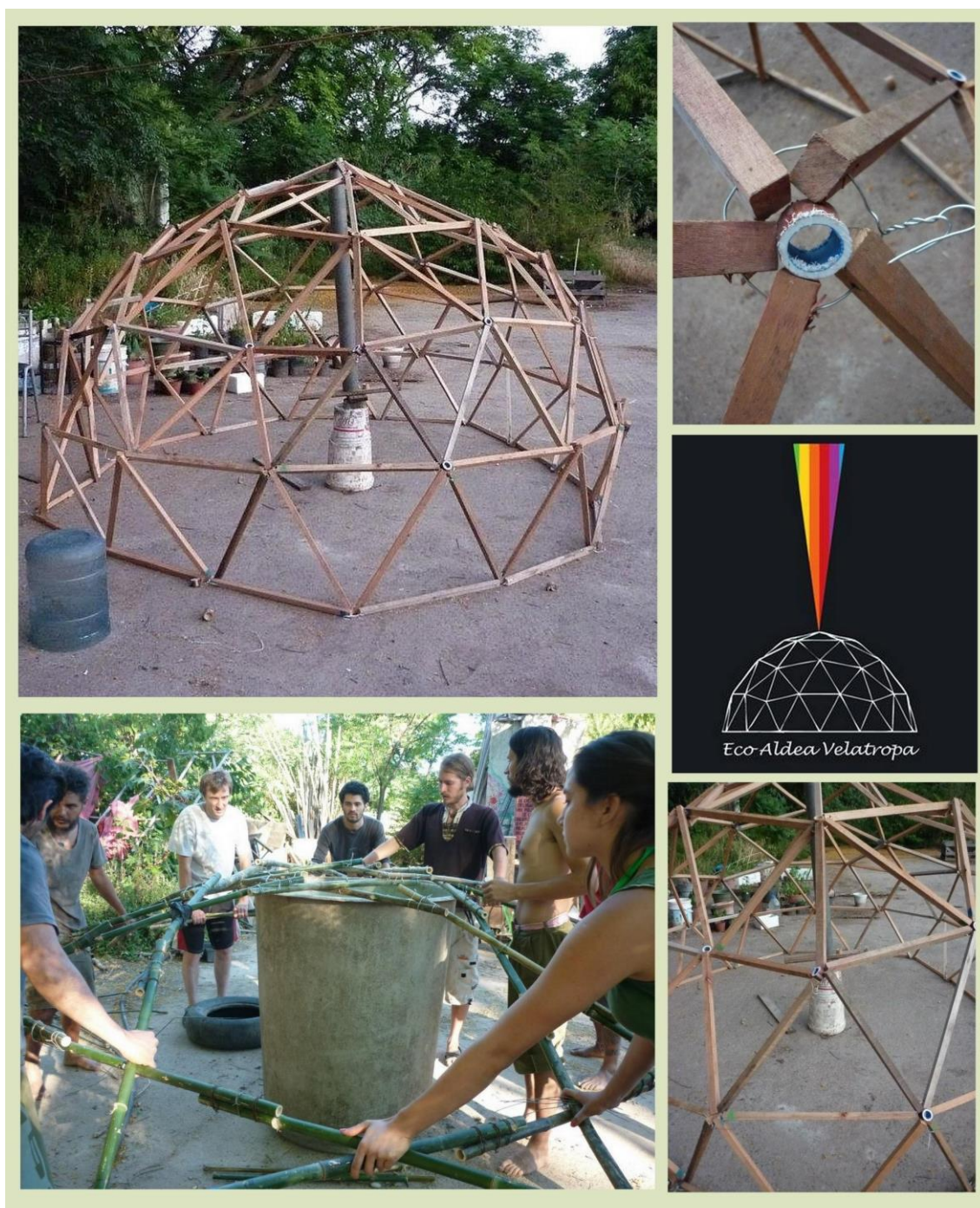
Construcción de domos tanto en madera como cañas de bambú
