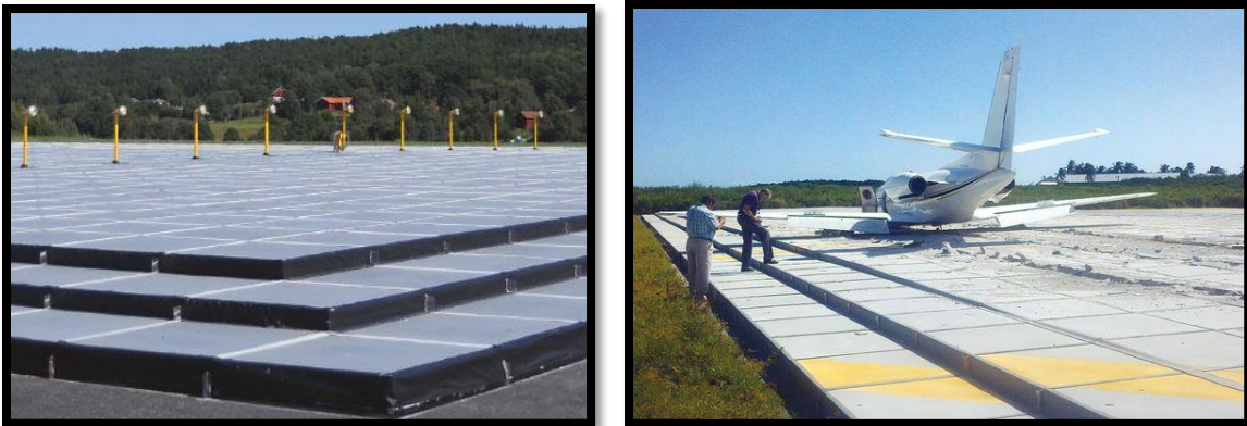
Figura 19 y 20: Sistema de contención de aeronaves (EMAS).
