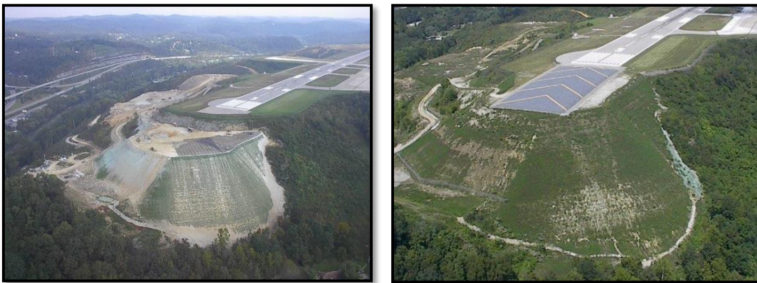
Figura 21: Construcción EMAS en el aeropuerto de Charleston. Fuente: Tencate [11]
