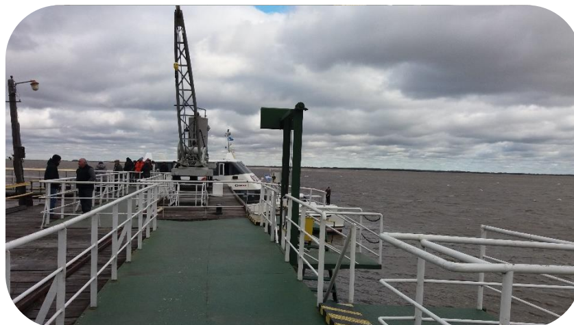
Fotografía 29: Muelle de la isla
