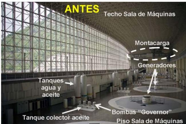
Fig.36. Sala Máquinas antes accidente
