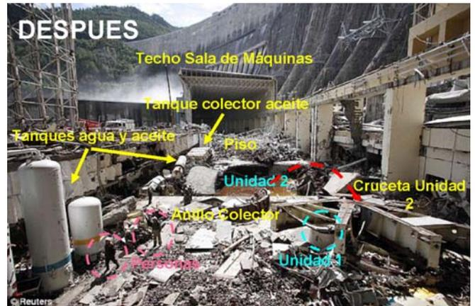
Fig.37. Sala Máquinas después accidente
