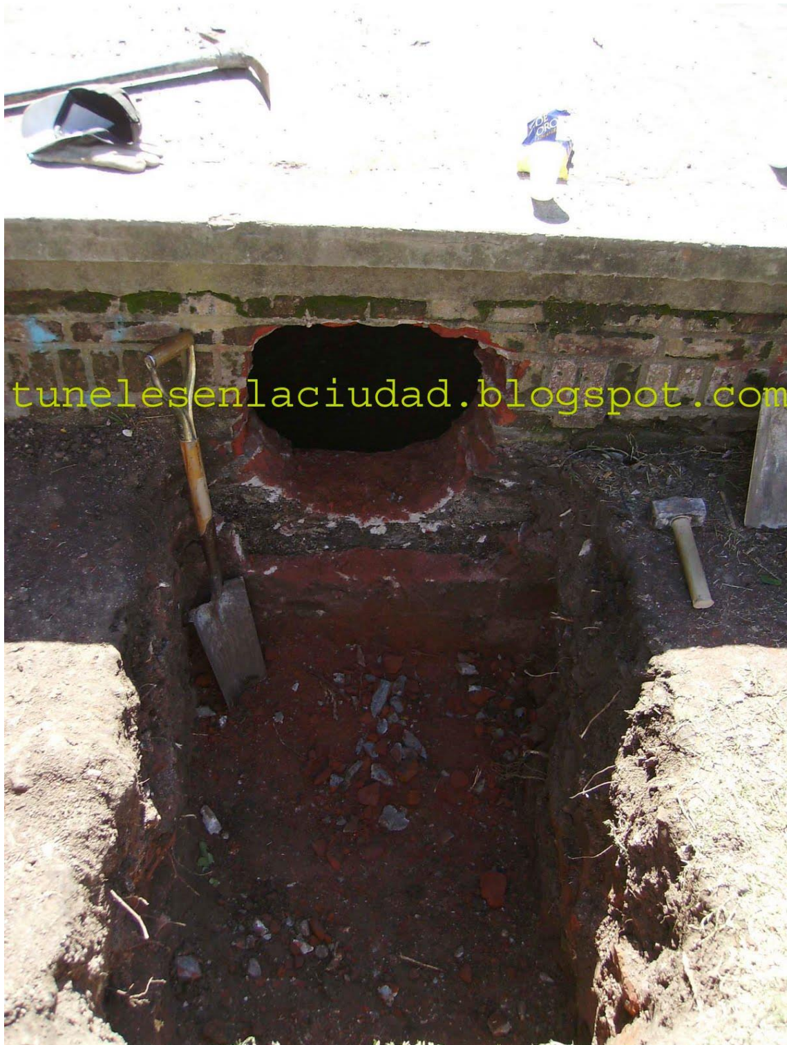
Fotos del Tunel de Plaza Islas Malvinas
