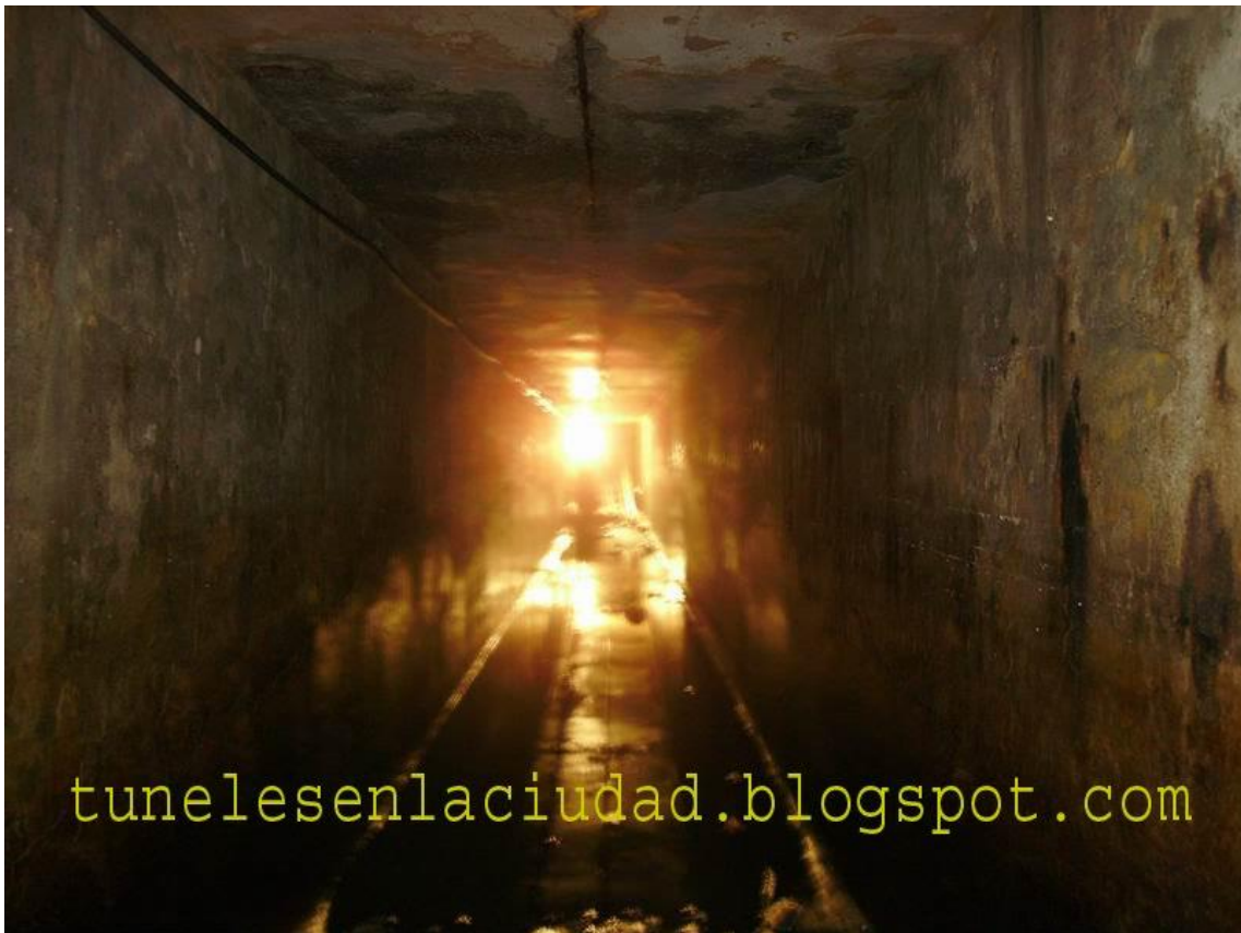
Fotos del Tunel de Plaza Islas Malvinas
