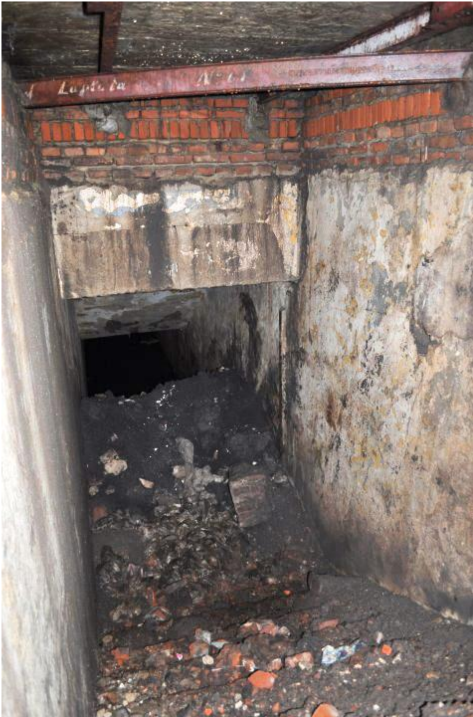
Túnel Plaza Islas Malvinas
