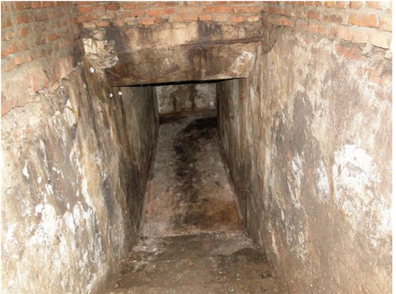
Túnel Plaza Islas Malvinas
