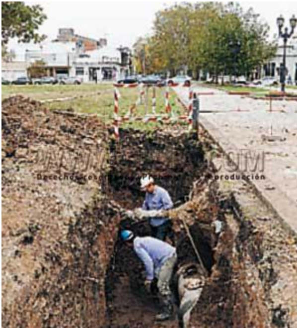
Excavaciones para hallar el túnel de Plaza Islas Malvinas.
