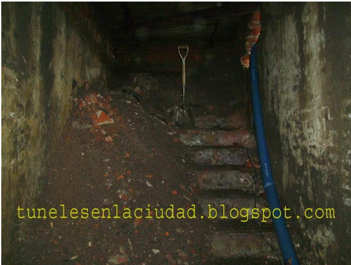
Fotos del Tunel de Plaza Islas Malvinas
