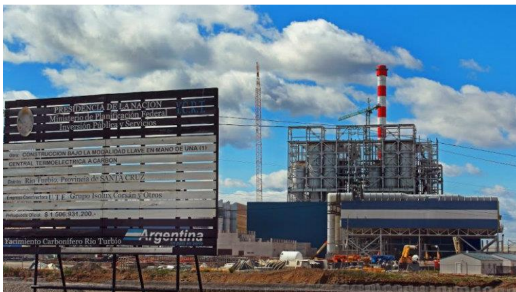
Figura 7.4. Central Termoeléctrica a Carbón. El Espejo Diario (s.f.), recuperado de elespejodiario.com/presentan-accion-de-amparo-por-la-termoelectrica-a-carbon-de-rio-turbio/ [consultado 14/06/2019].
