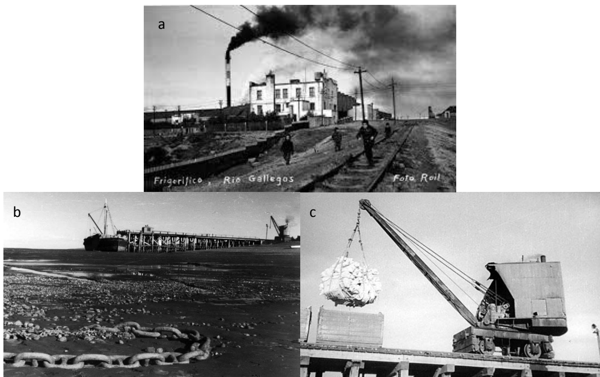
Figura 7.5. Fotografías de la infraestructura de apoyo a la ganadería, en Río Gallegos tomadas en primera segunda mitad de siglo XX. A) Frigorífico Swift, b) Muelle Swift, c) Grúa a vapor cargando en Muelle Swift. Fotografías tomadas por Walter Roil. Disponibles en Archivo Roil.
