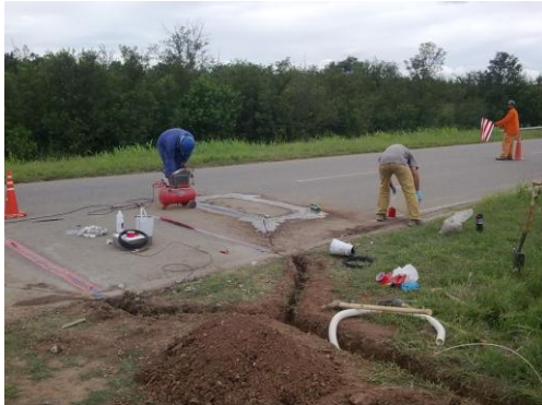
Ilustración 7: instalación de sensores
