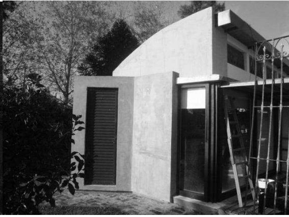
Figura 7: Cara noreste de la vivienda con EIFS.
