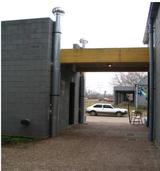
*Fig. 5 – Turbinas eólicas al tope de tubos exteriores*
