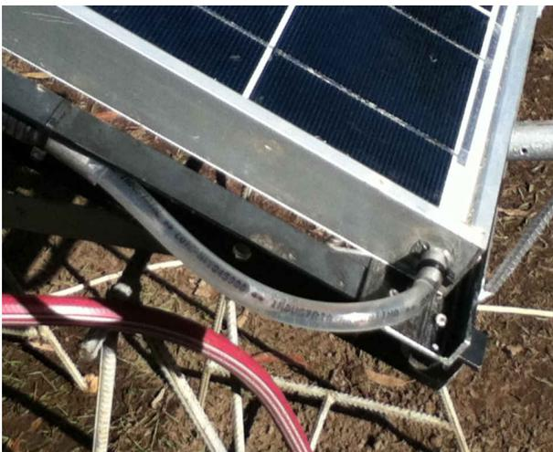
*Figura 5a: Detalle conexión entrada de agua.*
