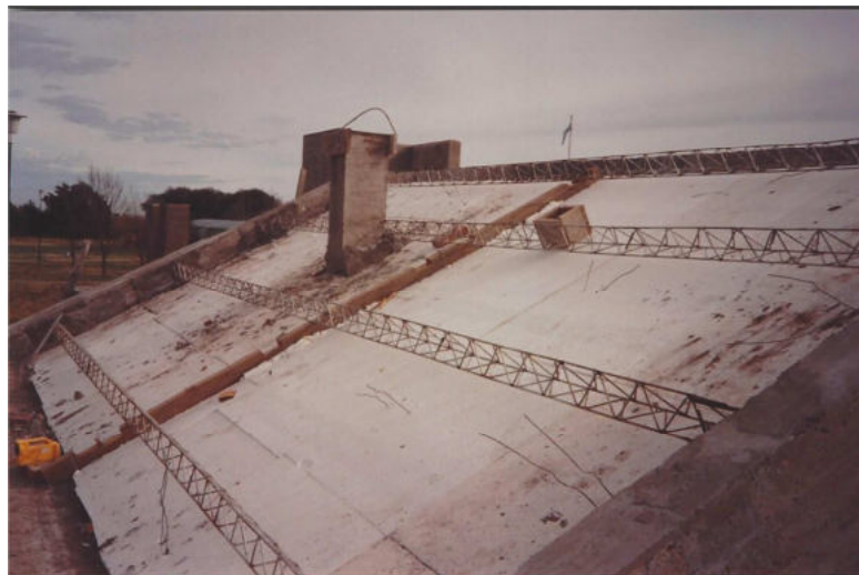
Figura 9: detalle de la cubierta en el área laboratorio durante su construcción.
