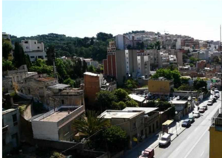
Figura 1. Construcciones sobre las colinas del barrio Vallcarca, Distrito de Gracia, Barcelona
