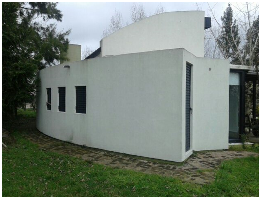
Fig. 1 Vista S del muro rehabilitado
