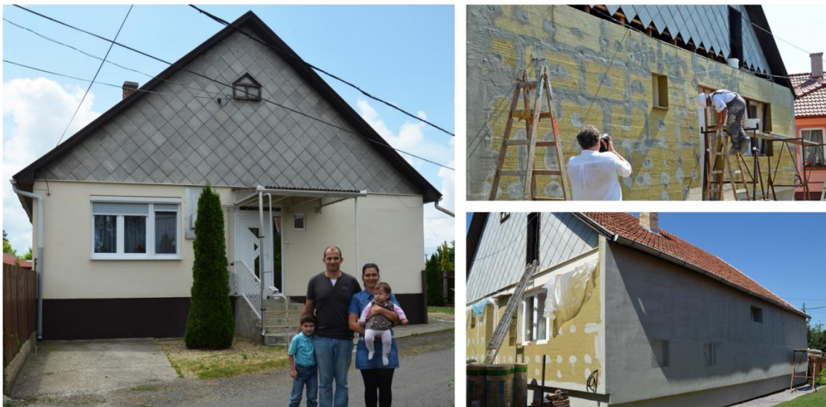
1. ábra Hajdúnánási családi ház homlokzati hőszigetelése
