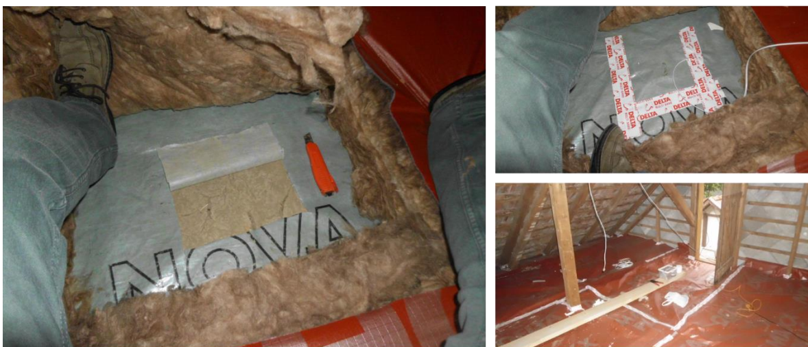
7. ábra Födémhőszigetelés készítése és monitoring pontok elhelyezése
