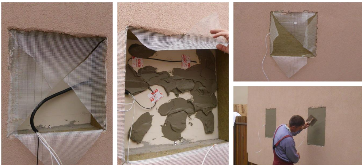
3. ábra Szenzorok elhelyezése szerkezeti monitoring méréshez
