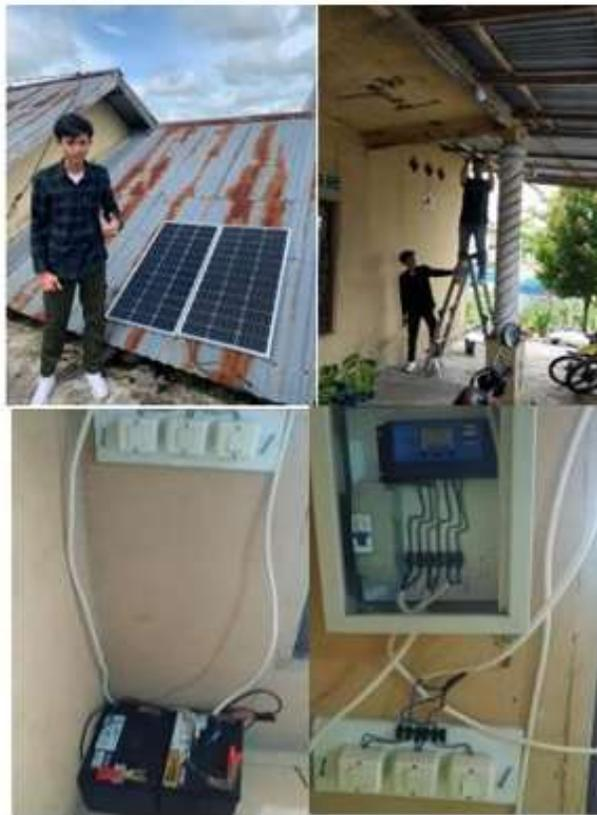
**Gambar 2. Pemasangan Instalasi PLTS**
