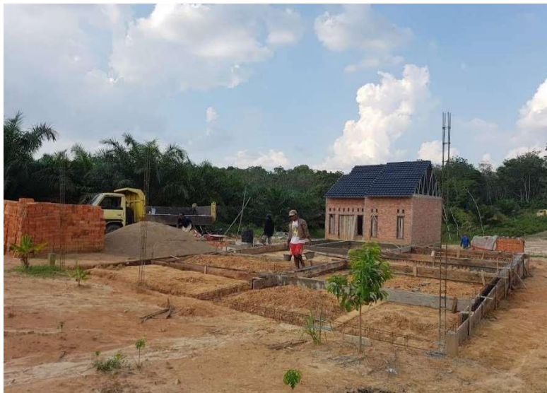
Foto Pengerjaan Pembangunan PT. Huqy Properti Syariah Jambi
