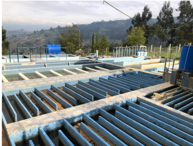
Figura 6. Planta de Tratamiento de Agua Potable Bayas (PTAP-B) Fuente: Elaboración propia
